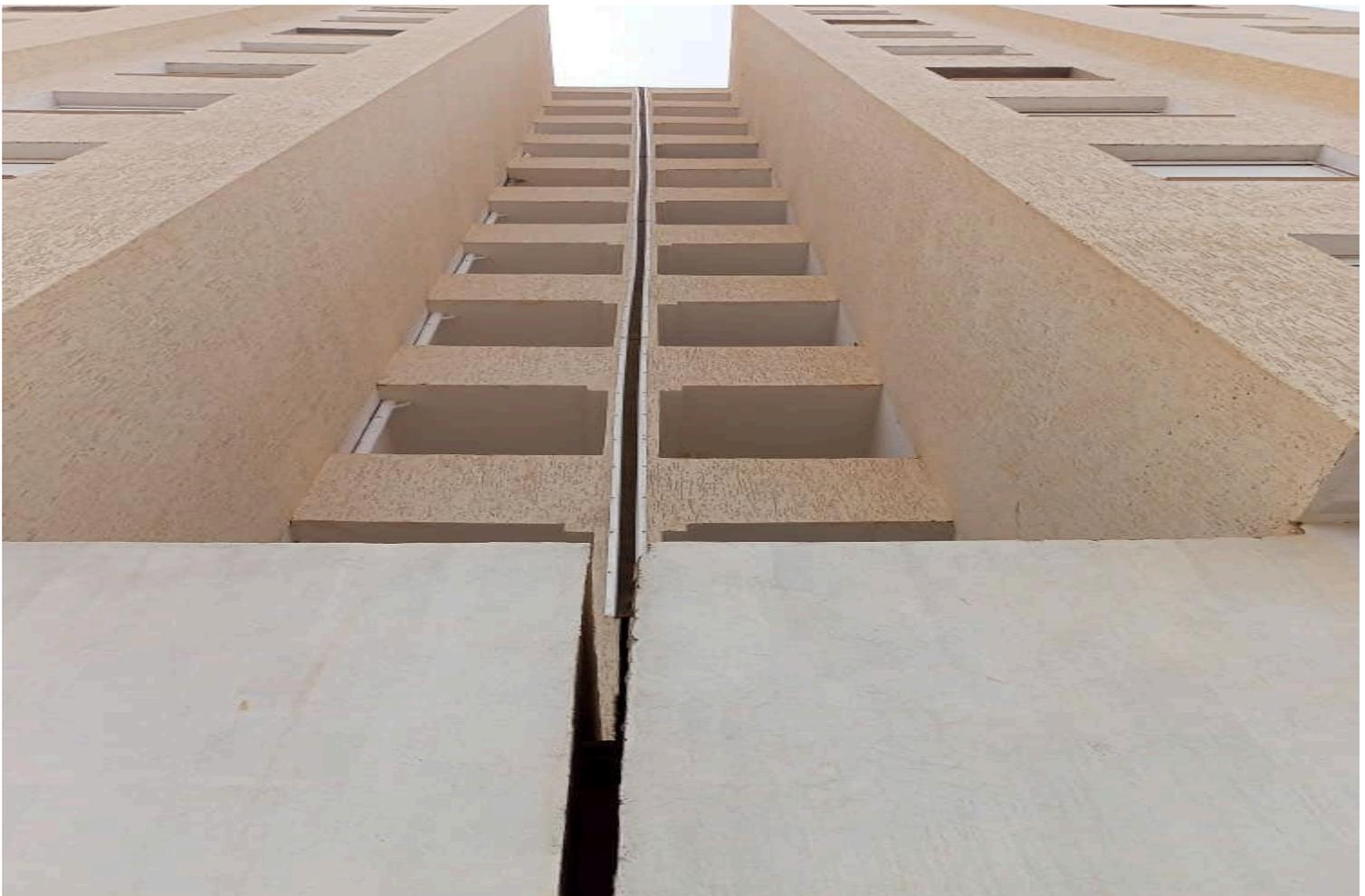
**Figure** le joint sismique entre les deux blocs
