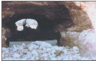
Figure 2.12 : Ouverture d'une brèche dans un barrage par renard hydraulique [29] .
