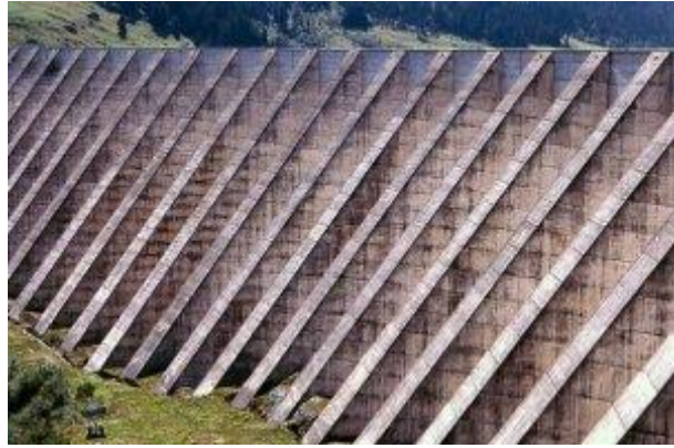
Figure 1.5 : Exemple de barrage à contreforts.
