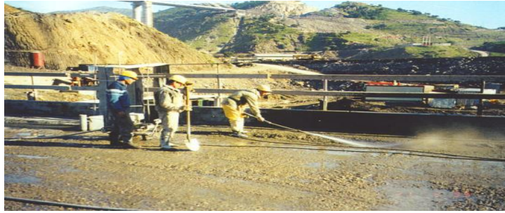
Figure 4.9 : Nettoyage des couches de BCR
