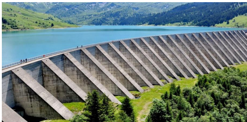
Figure 1.1 : Barrage de Roseland en Savoie [2] .
