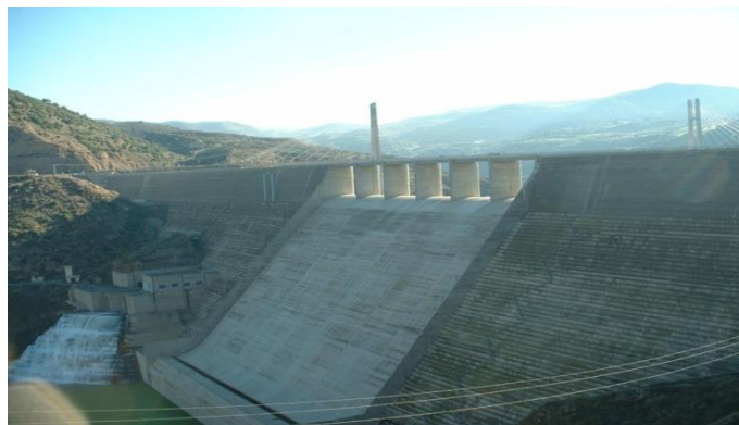
Figure 4.7 : Vue aval du barrage Béni Haroun.
