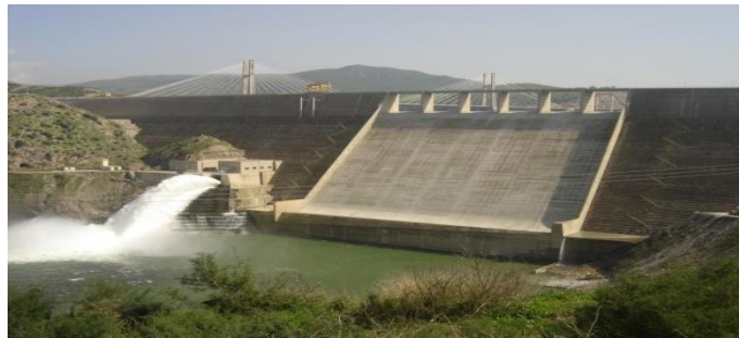
Figure 4.6 : Vue aval du barrage Béni Haroun avec fonctionnement de la vidange de fond.
