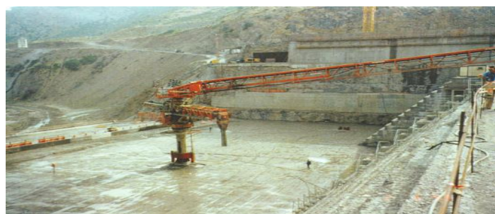
Figure 4.8 : Transport sur site par convoyeur du BCR.
