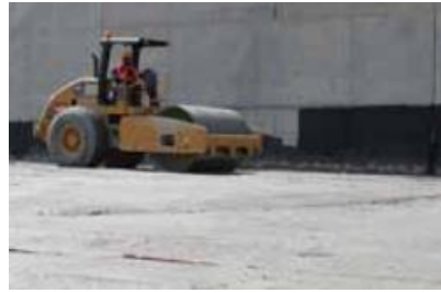
Figure 1.14 : Compactage de BCR à l'aide d'un rouleau vibrant [11] .
