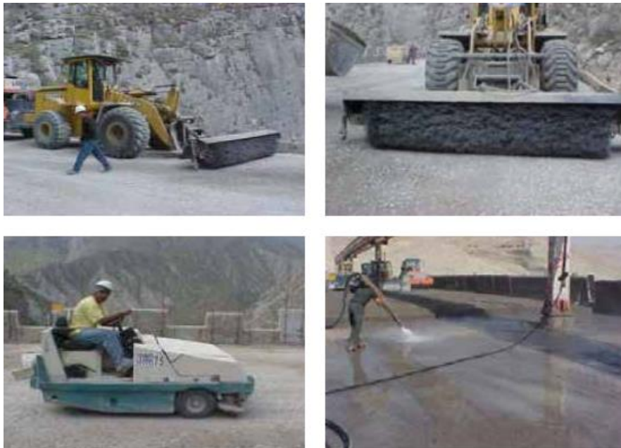
Figure 1.15 : Méthodes de nettoyage des surfaces des couches [11] .
