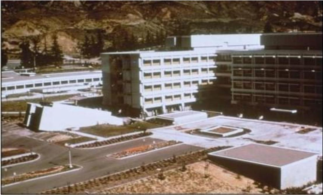
**Figure 1-1** : la tour de l'hôpital effondrée à cause de l'insuffisance du joint sismique causé par un entreoquement entre la tour et le bloc qui l'avoisine (séisme de San Fernando) 1971[5]
