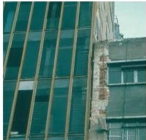
**Figure 1-2** : a) l'immeuble moderne en béton armée à gauche. S'est effondré suite aux chocs avec l'ancien bâtiment très rigide à droite, b) l'entreoquement entre deux bâtiments à cause du joint sismique insuffisant. (Mexico en 1985).[7]
