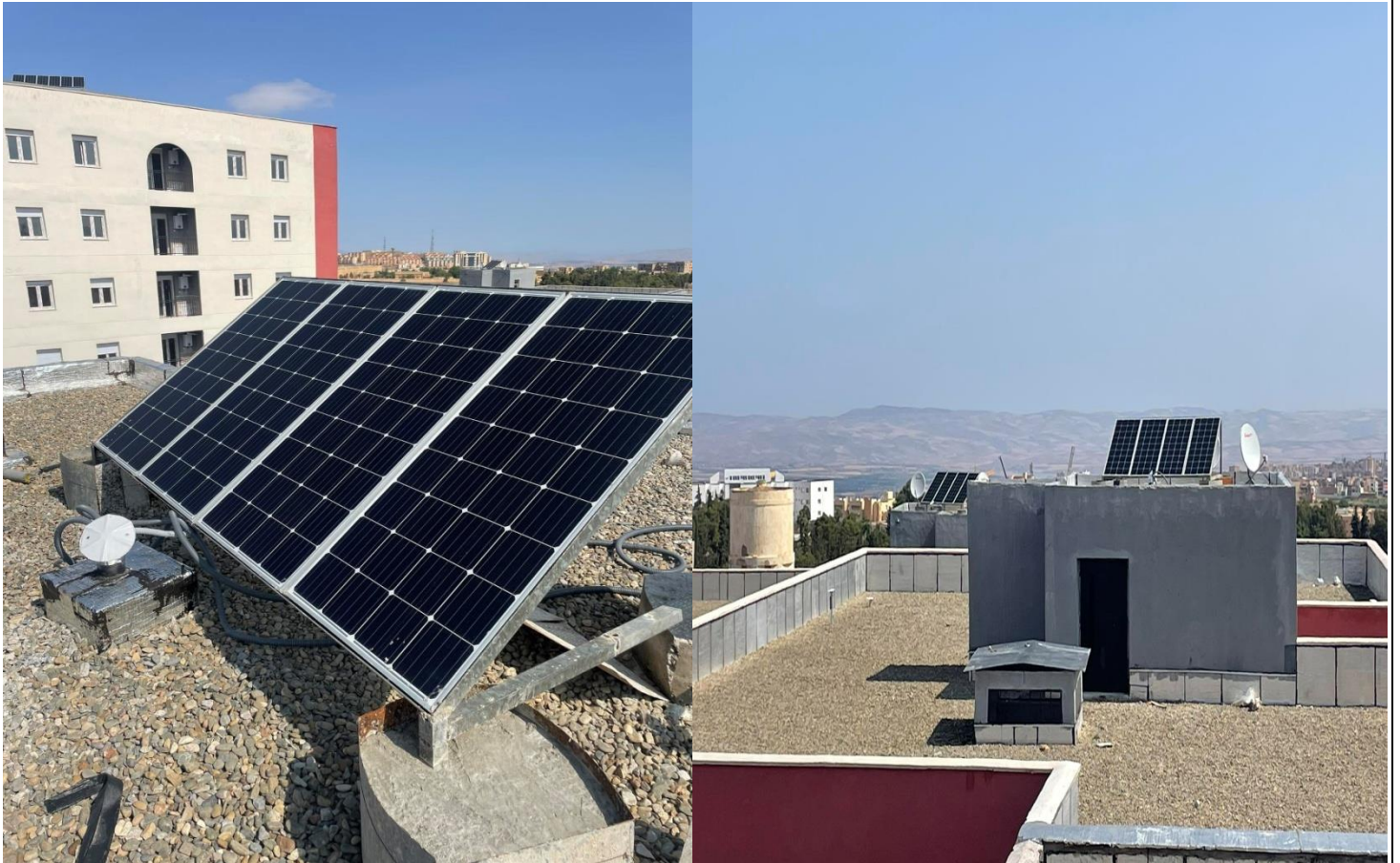
Figure 18 : Installation des panneaux Photovoltaïque pour le projet de logement de l'EMPI
