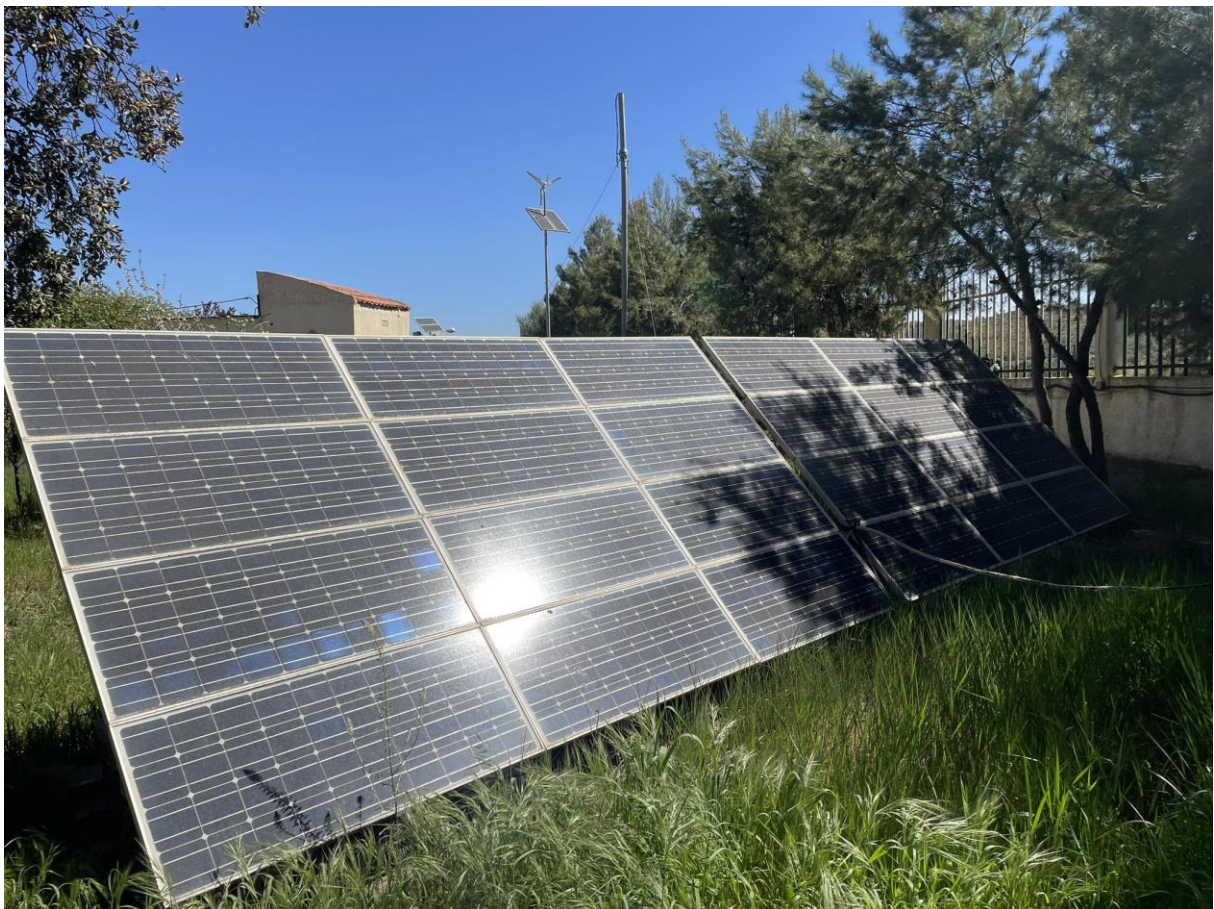
Figure 14 : installation des panneaux photovoltaïque a zerifat
