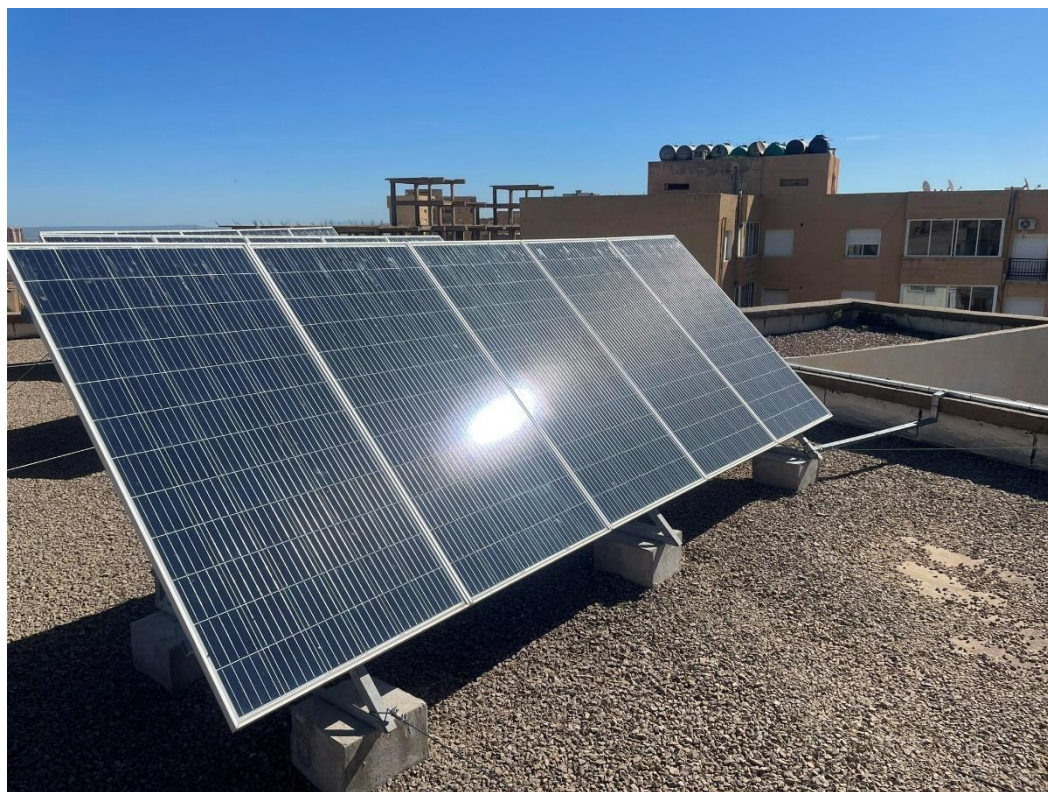
Figure 23 : installation des panneaux photovoltaïque chez Sonelgaz Imama Tlemcen
