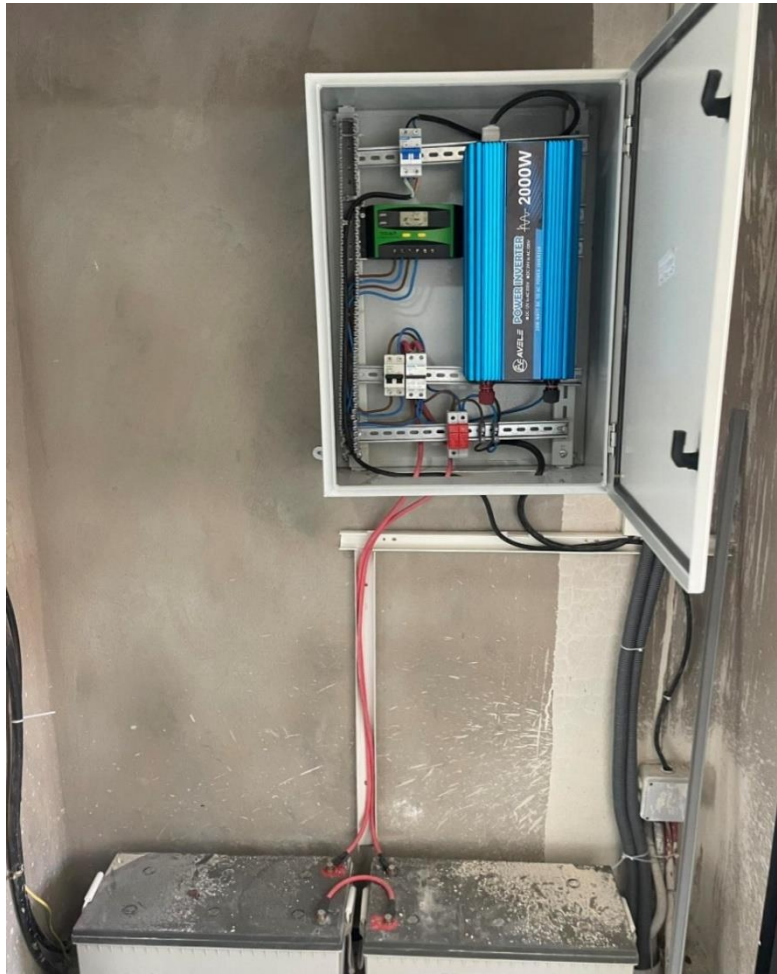
Figure 19 : système de stockage d'énergie
