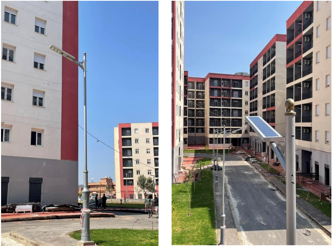
Figure 21 : éclairage public alimenter par des panneaux photovoltaïques
