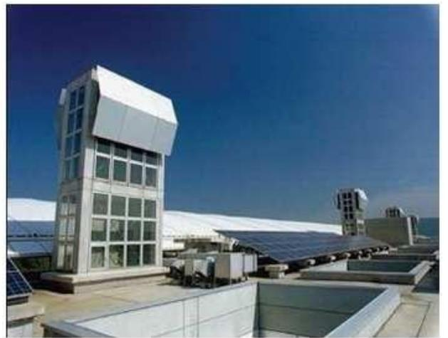
Figure 1.15 : Exemple de cheminée solaire intégré sur le bâtiment. [9]
