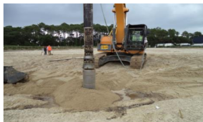
Figure 1.22 : Remplissage de l'affaissement conique par un matériau d'apport
