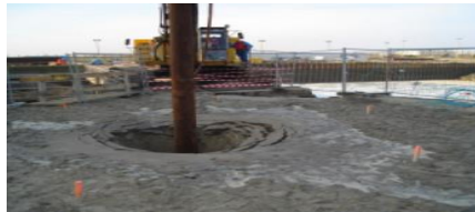
Figure 1.23 : Le cône d'affaissement autour de vibreur
