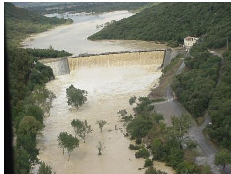
Figure 1.4: Une rupture de barrage La Verne, France
