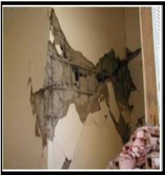
Figure 1.6 Fissures ouvertes dans le voile (10)
