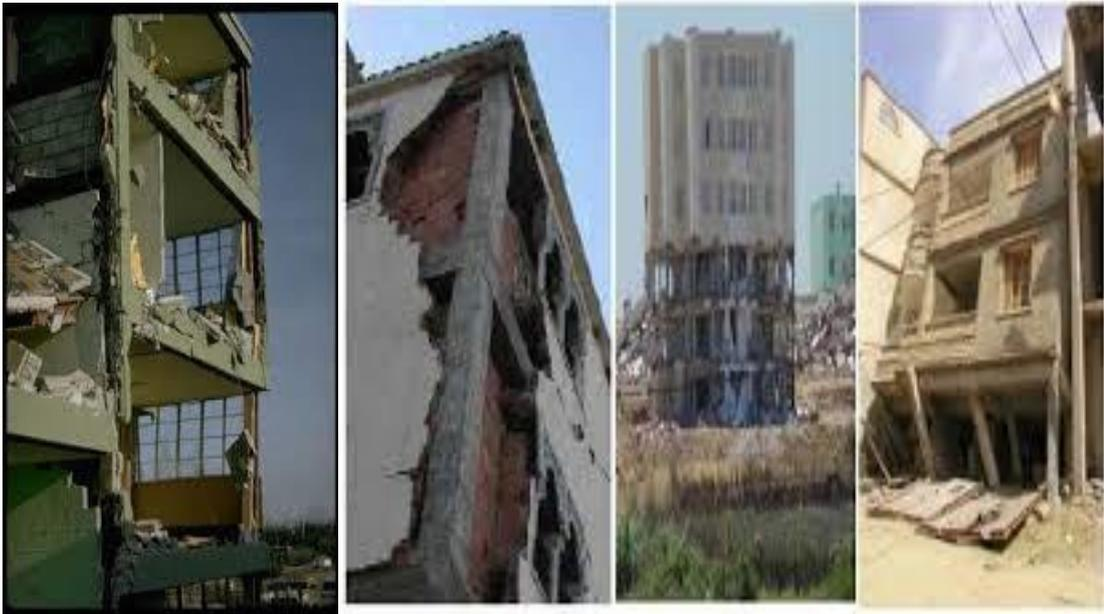
Figure 1.1 : Influence de la disposition des voiles sur la performance sismique des bâtiments (1)
