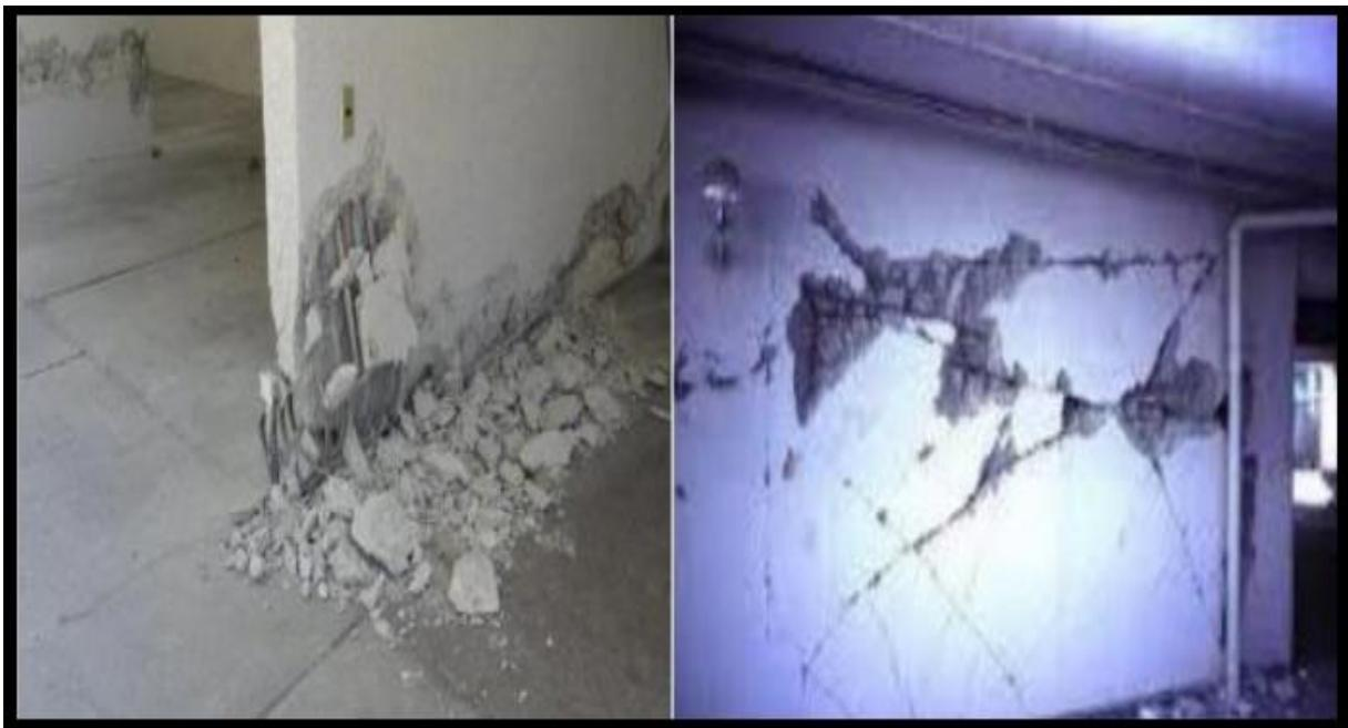
Figure 1.9 : Dégâts subis par les voiles. (11)
