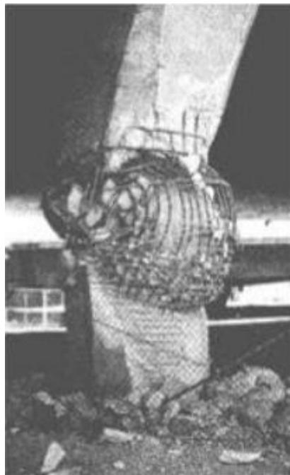
Figure 1.24 : Exemple de rotule plastique dans une pile de pont. (24)
