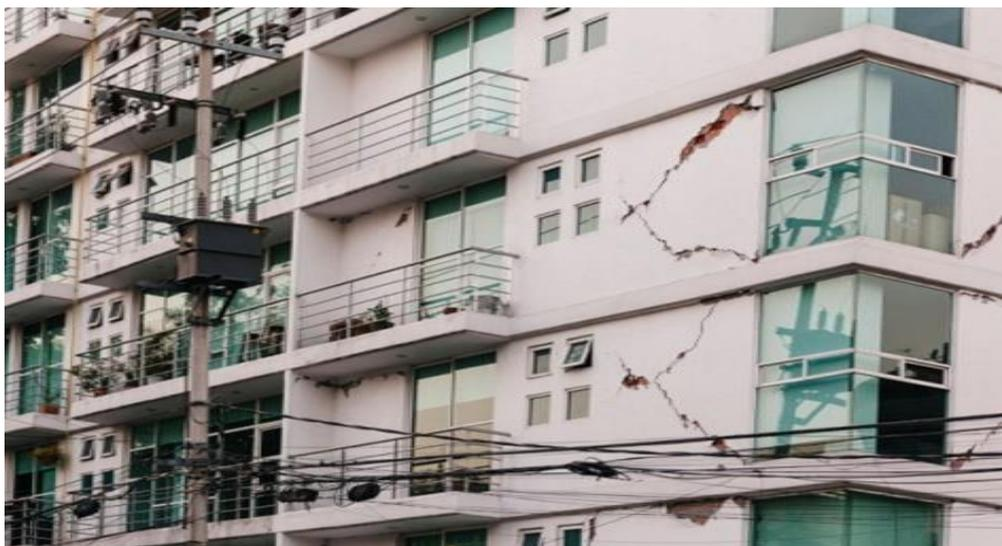
*Figure 1.4 : Les ruptures et fissures subis aux voiles. (8)*
