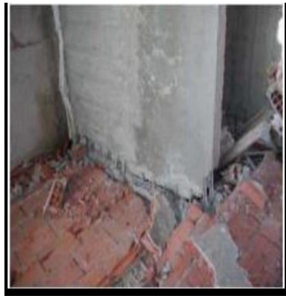
Figure 1..17.Rupture de section à la base des voiles (10)
