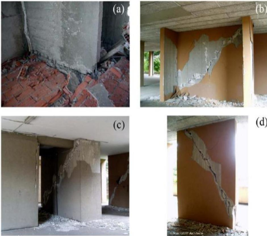
Figure 1.5 : Dommages subis par les voiles (a) Rupture de section à la base du voile (Séisme de Boumerdès du 21/05/2003) ; (c) endommagement aux niveaux de nœud poteaux forte poutre faible. (b-d) : Rupture en cisaillement des voiles (Séisme de L'Aquila 06/04/2009). (8)
