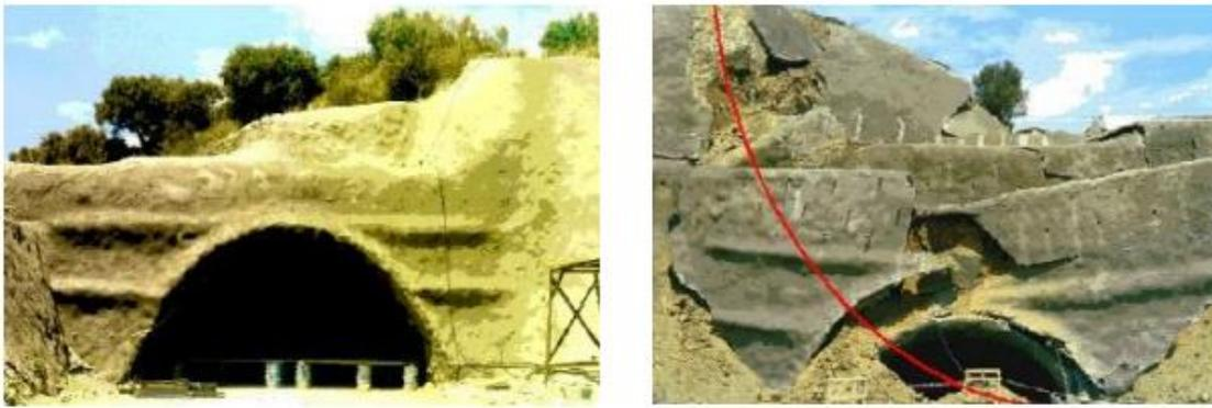
Figure 1.2 Tunnel de Patra avant et après l'effondrement (Grèce, août 1998)
