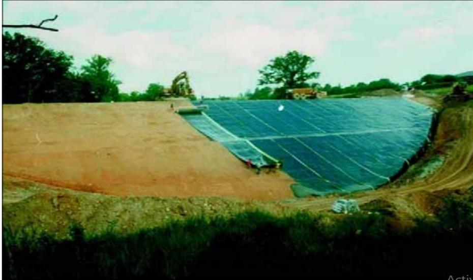
**Figure I.22:** Mise en place d'une géomembrane bitumeuse[4]
