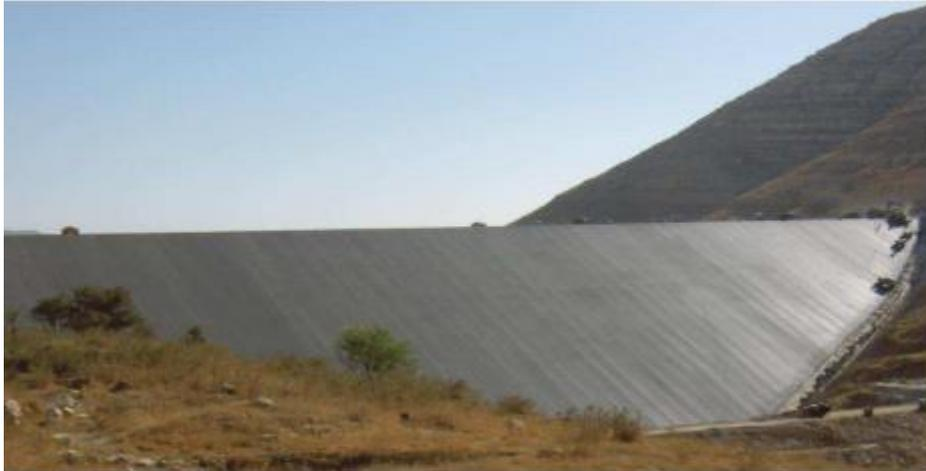
**Figure I.21:** Masque en béton bitumineux du barrage Chabrouh (2007) Liban cité par [48]
