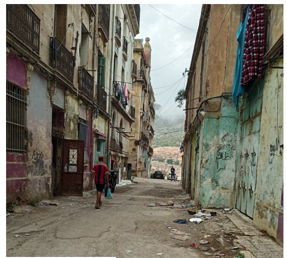
Figure SEQ Figure \* ARABIC 36 façades dégradés
