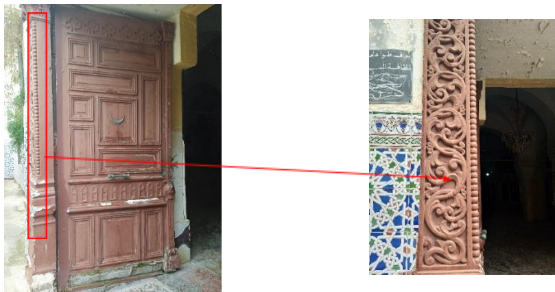
Figure SEQ Figure \* ARABIC 64: accès à la salle de prière
