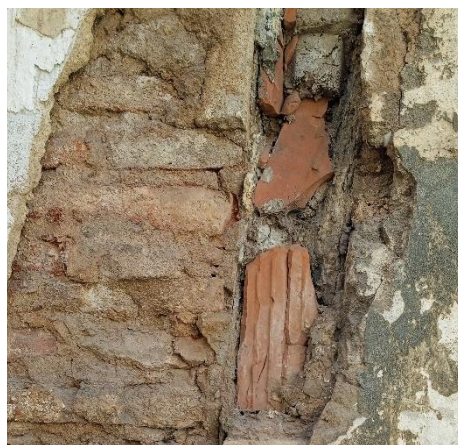
Figure SEQ Figure \* ARABIC 56: mur nu dévoilant la pierre comme matériau de construction de base
