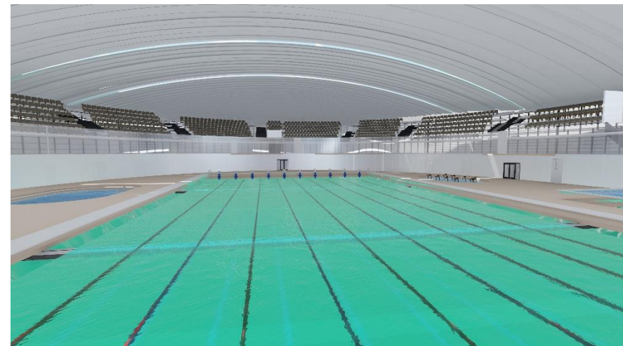
Vue sur les piscines
