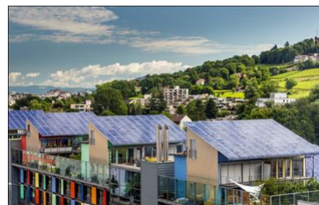
Figure 27 Eco quartier de Vauban
