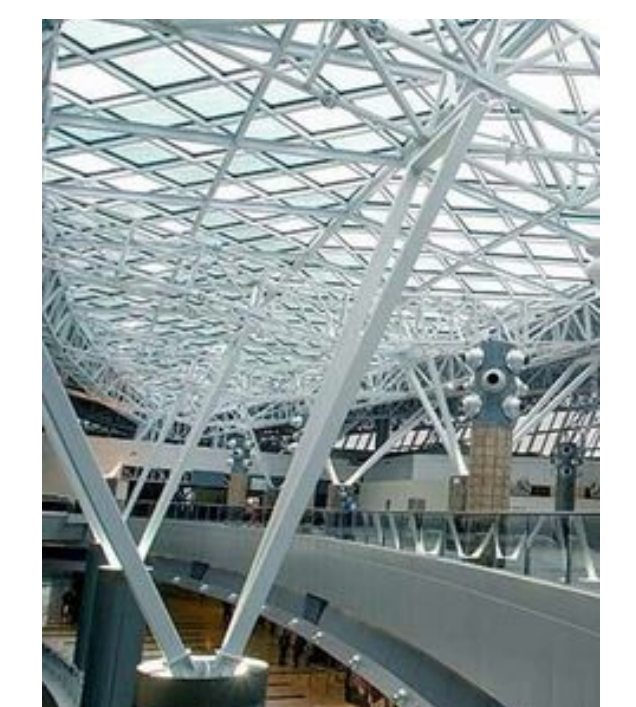
double poteaux métalliques
