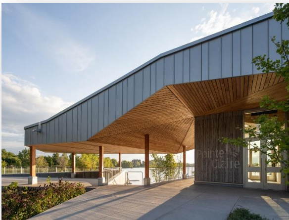
Figure 91 La forme du bâtiment Baie de valois Source : Archidaily
