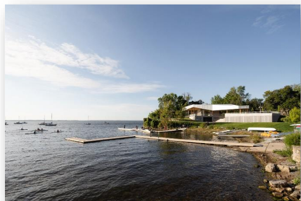
Figure 87 Centre nautique Bais de valois Source : Archidaily
