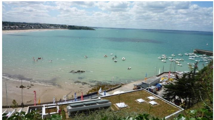
Figure 75 La toiture du bâtiment
