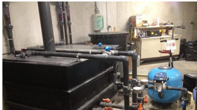
Figure 127: station de filtration mécanique et biologique pour aquarium géant.
