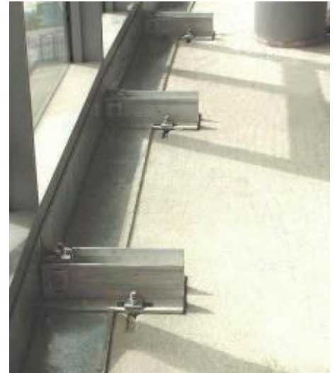
Figure 118 : fixation mur rideau sur plancher
