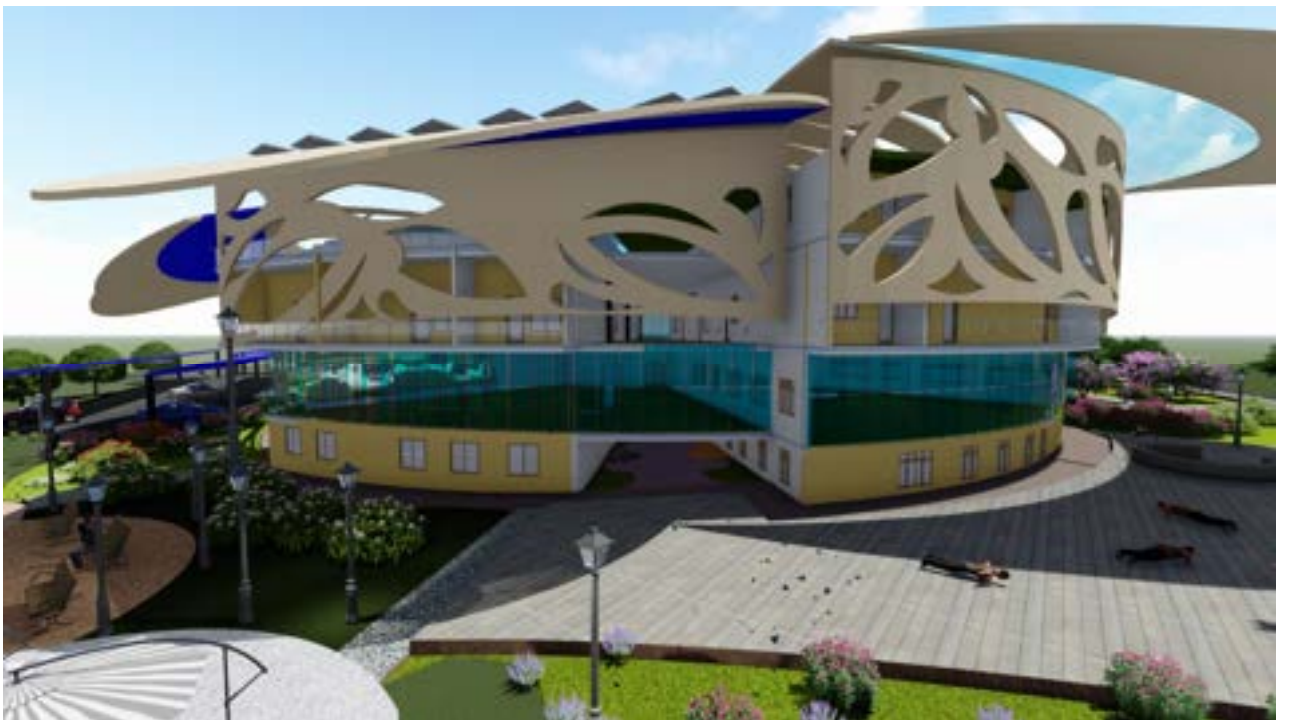
Vue sur la façade latérale
