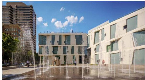
Figure 116 : Récupération de l'eau dans Glassell School
