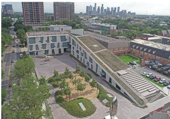
Figure 114 : Toiture jardin du Glassell School of Art
