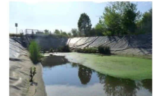
Bassin de récupération
