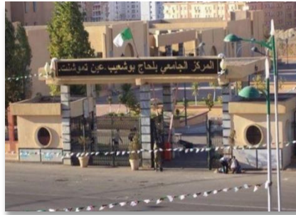
Figure 77 : Université Belhadj Bouchaib
