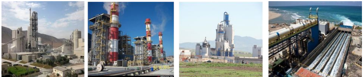
Figure 56 : Les infrastructures industrielle a AIN TEMOUCHENT
