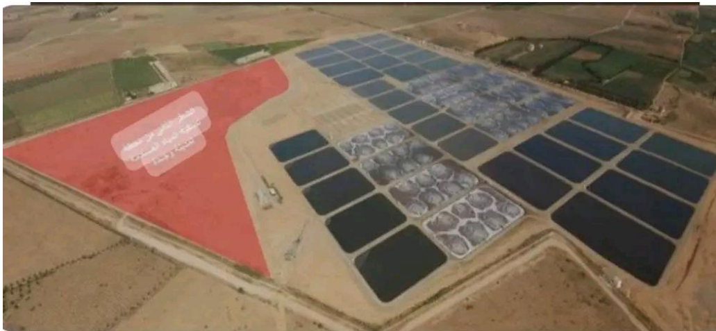
Figure 10 : La station d'épuration des eaux de Oujda
