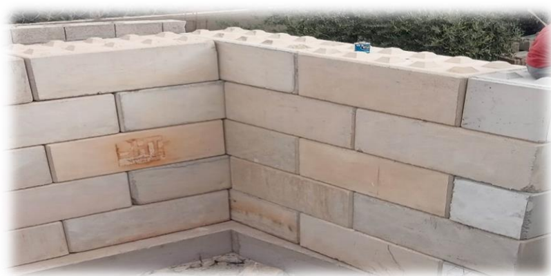
Fig.12 : Recyclage de déchets inertes en forme de bloc LEGO
