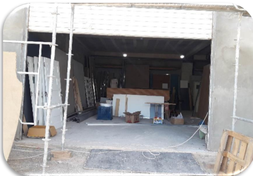
Fig.05 : atelier ferronnerie de l'entreprise BHT
