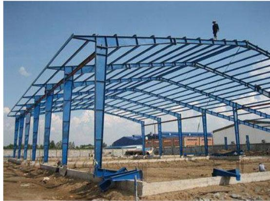
Figure 16: Construction par portique
