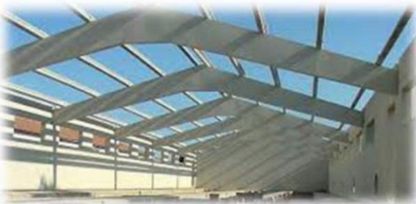
**Figure 21:** Portique en béton
