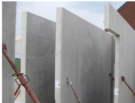
**Figure 24:** Panneau en béton plein
