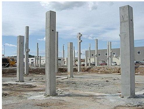
Figure 29: Poteaux préfabriqué
