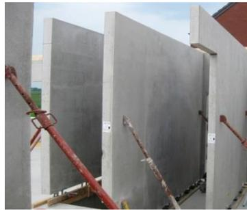
**Figure 31:** Mur préfabriqué
