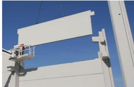
**Figure 22:** Construction par panneaux
