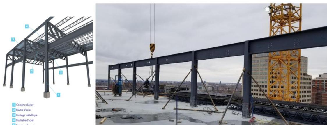
**Figure 109:** Structure métallique
