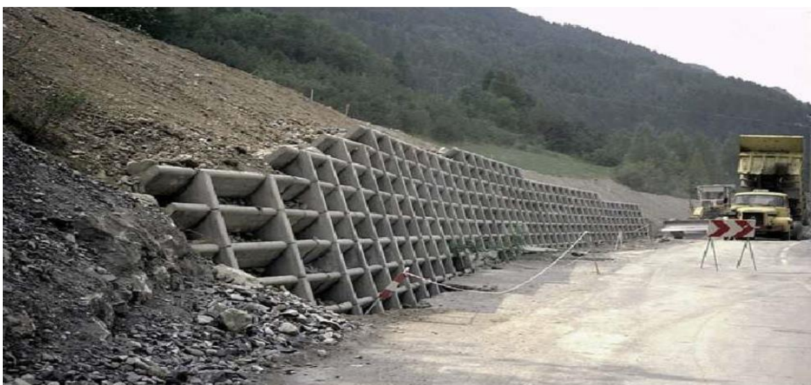
Figure 1.14: Mur en éléments préfabriqués empilés (mur Delta). [2]
