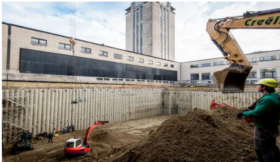
Figure 1.12: Mur en parois de pieux sécants. [8]
