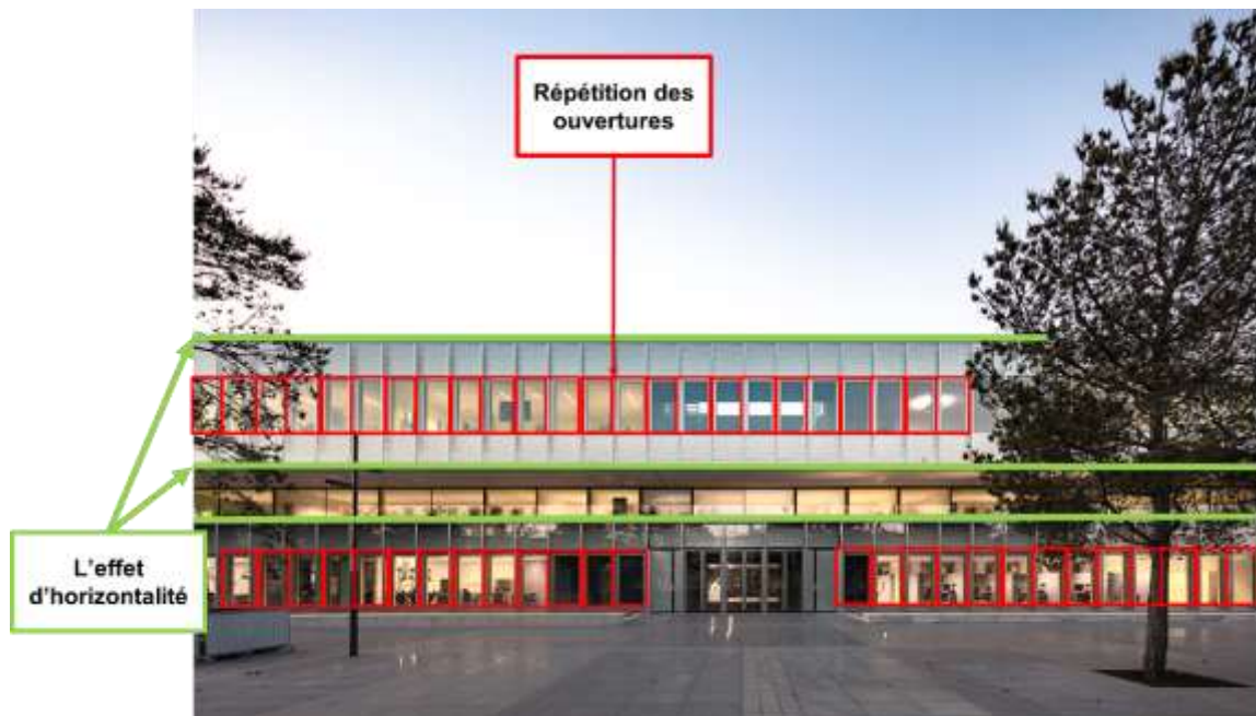
Figure 53: La façade du CMA.
