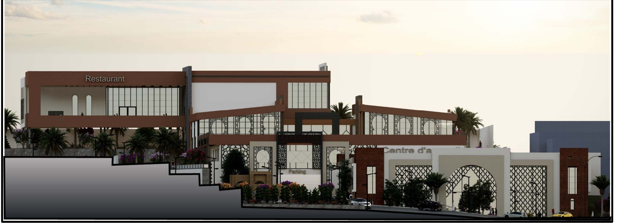
Façade principale Nord
