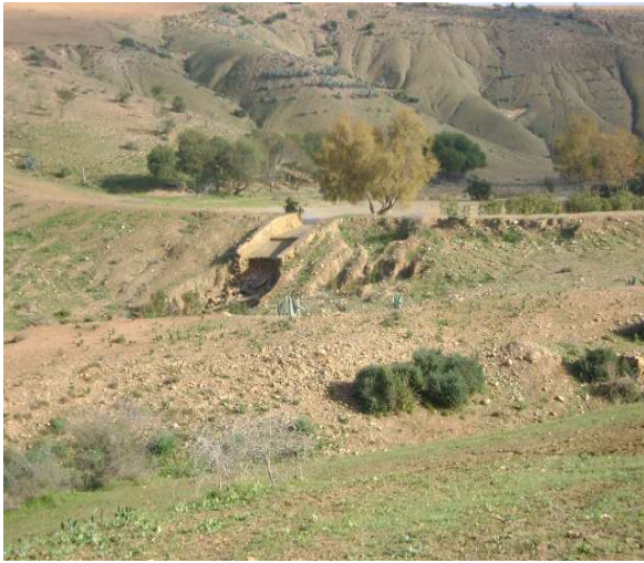
Photo 22 : seuil en terre avec un déversoir cimenté. Vue aval. Cliché Zékri N. Magnia11/12/2012
