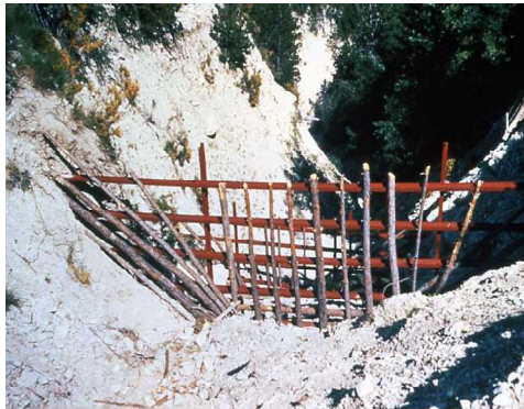
Seuil en piquets en bois et en fer
