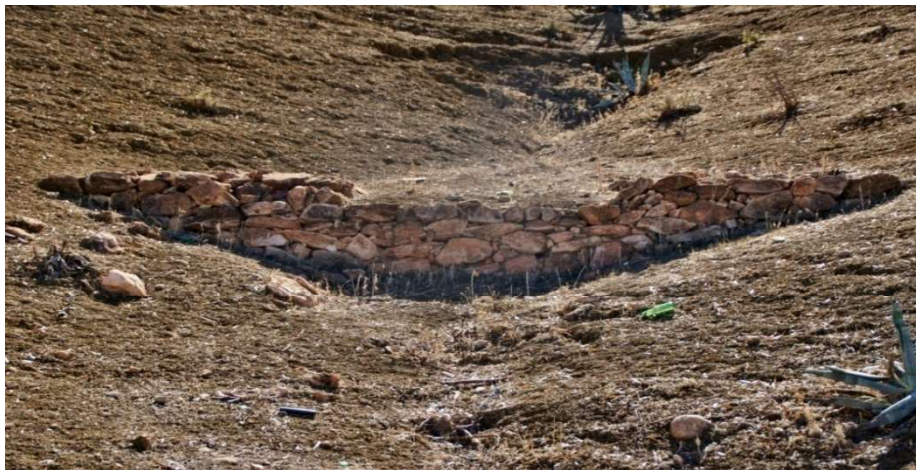
Photo 19 : Seuil en pierres sèches avec un déversoir* de forme trapézoïdale.
