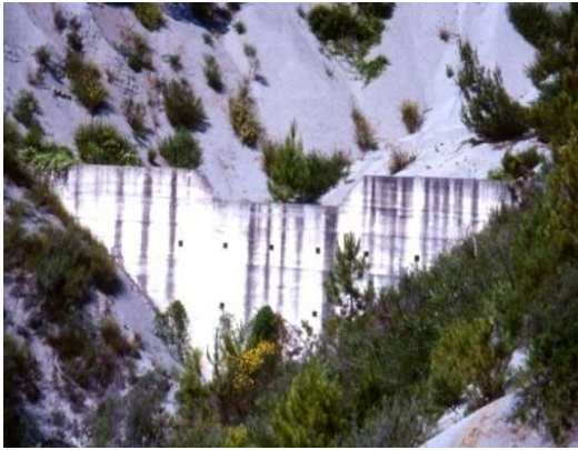
Seuil en béton
