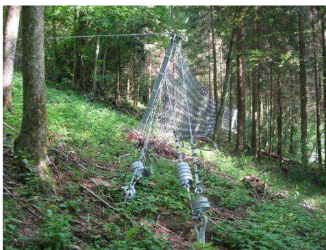
Écran pare-blocs en filet de type Turner
