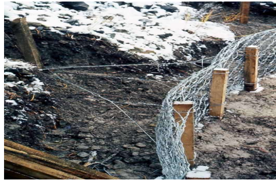
Seuil en filet de fer renforcé par des piquets en bois
