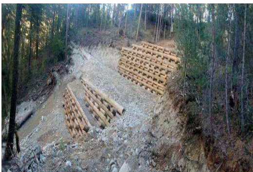
Gabion en bois
