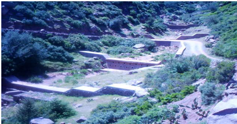
Photo 21 : seuil en pierres sèches, renforcé par du béton.
