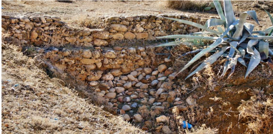
Photo 18 : Seuil en gabion avec un déversoir* de forme trapézoïdale.
