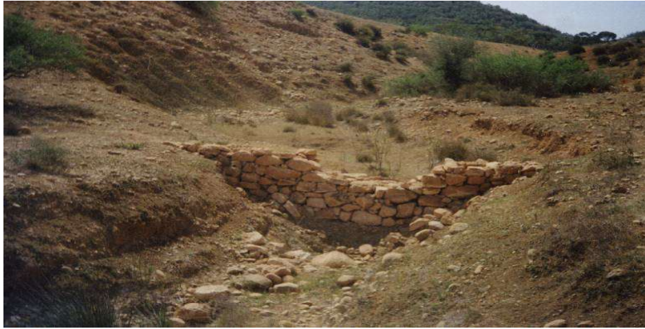
Photo 20 : Seuil en pierres sèches avec un déversoir de forme curviligne.
