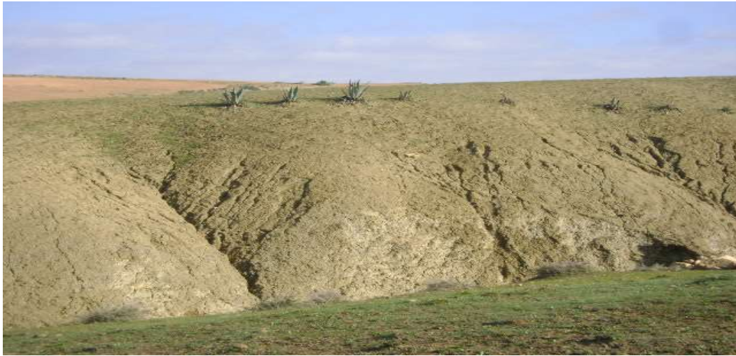
Photo 4, 5 et 6 : Erosion en griffes et rigoles. Clichés Zékri N. : Maghnia 11/12/2012
