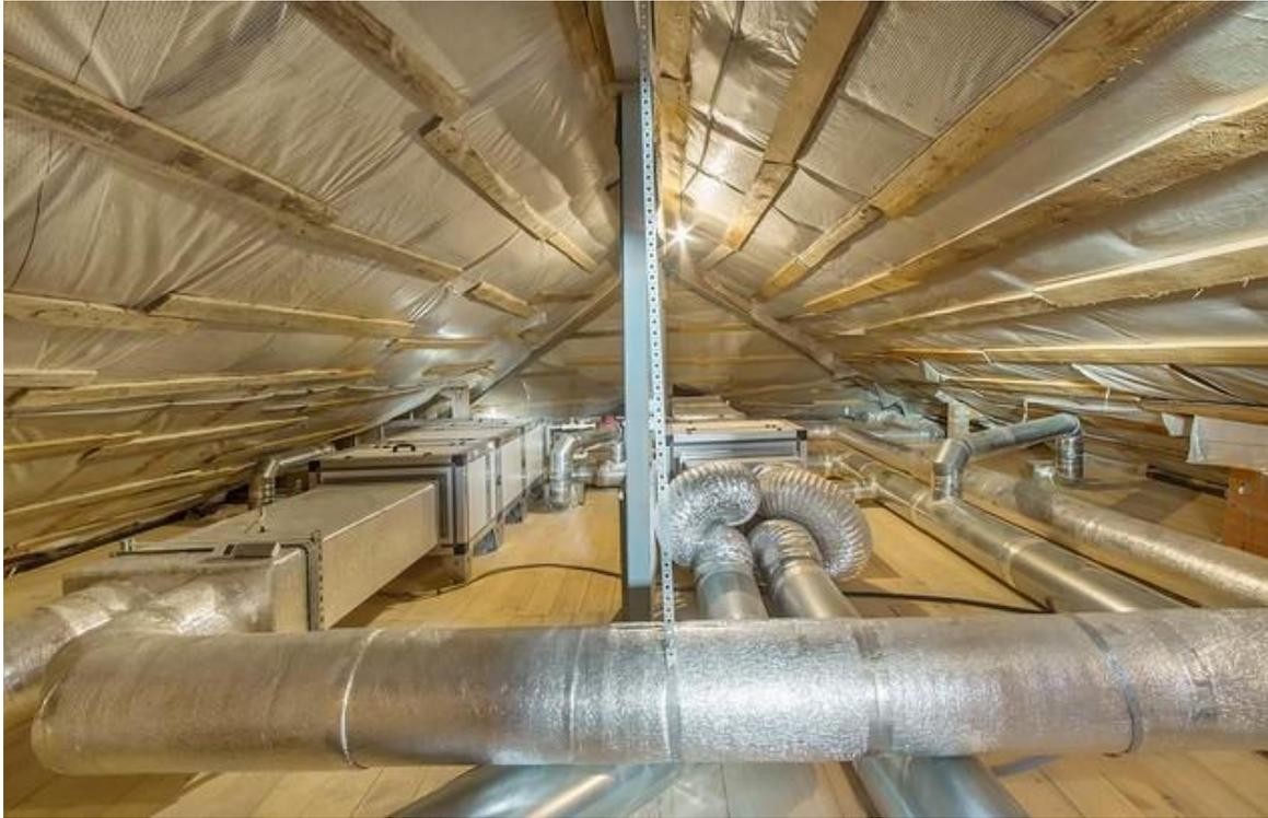
**Figure 95** L'installation discrète du climatisation gainable (source : <https://www.espace-aubade.fr/fiche-conseil/fonctionnement-d-une-climatisation-gainable.html>)
