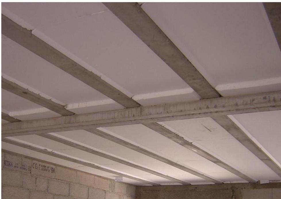
Figure 90 Poutre béton (source : <https://www.fabemi.fr/produit/poutre-raid7/>)
