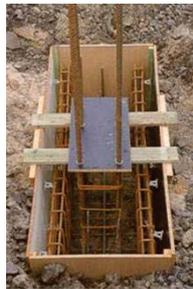
Figure 136 armatures en attente dans la fondation
