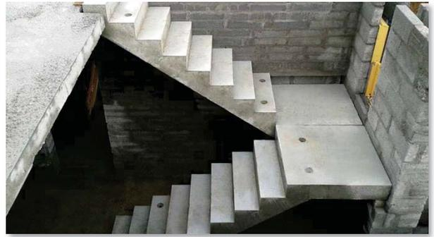
Figure 126 Les cages d'escaliers préfabriqués
