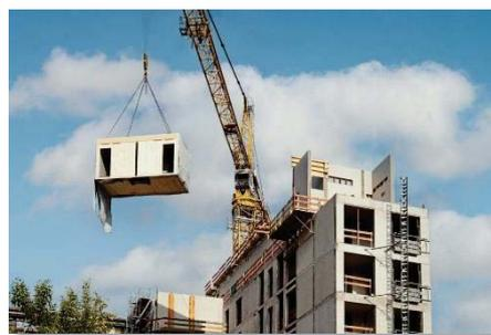
Figure 10 système modulaire
