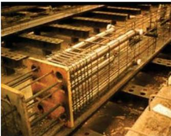
Figure 135 Gains dans la colonne pour insertion des armatures en attente
