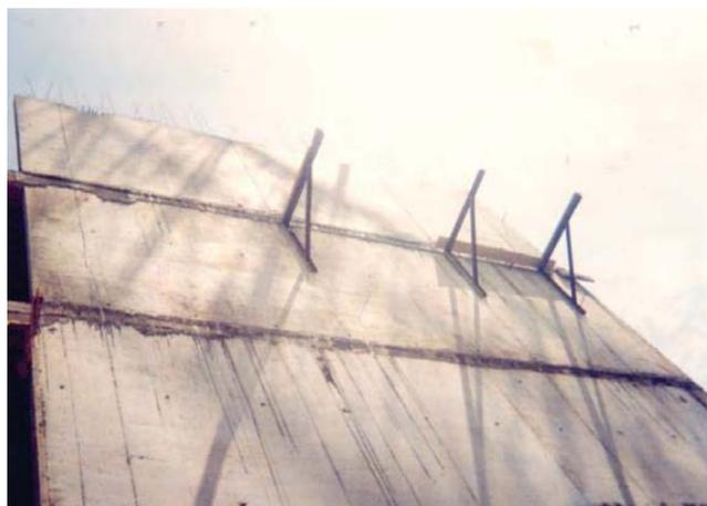
Figure 8 : Panneaux de façade de la hauteur d'un étage
