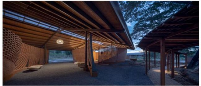
L'espace au milieu est transformé en une petite cour avec la fonctionnalité supplémentaire d'une salle d'attente. La structure en brique est partiellement perforée, gardant l'espace ventilé, confortable et aéré.
