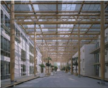
la ventilation naturelle.: utilisant des ouvertures zénithales
