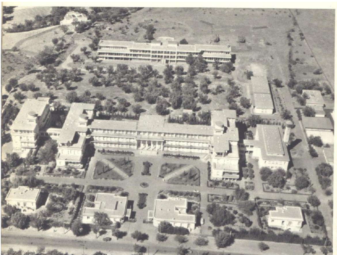
Figure 122: ancienne photo du CHU de Tlemcen 37
