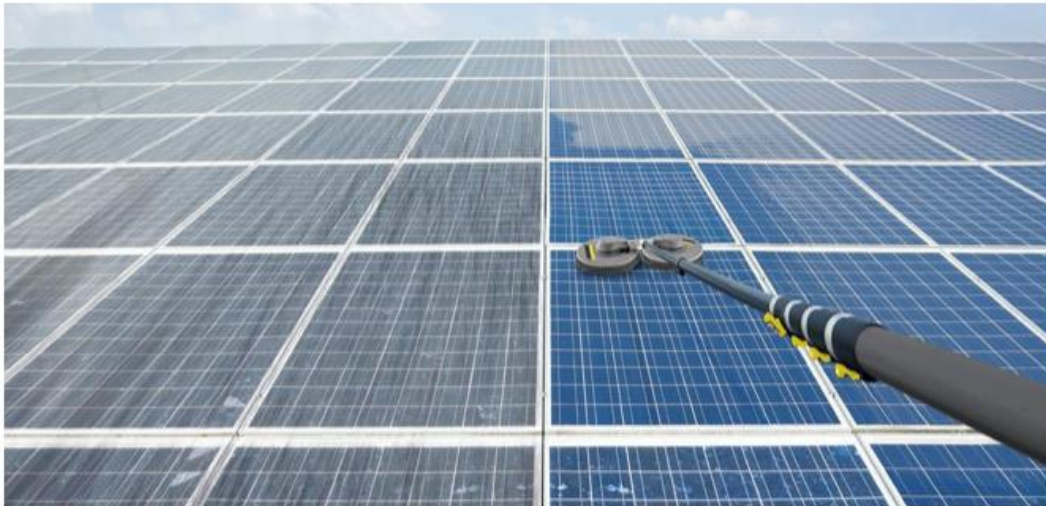
Figure II. 16 - Différence entre panneau encrassé et panneau nettoyée. [26]
