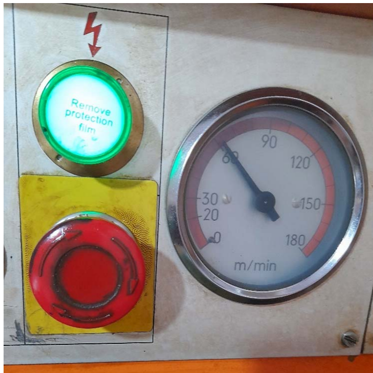
Figure V.13 Capteur de vitesse après l'intervention
