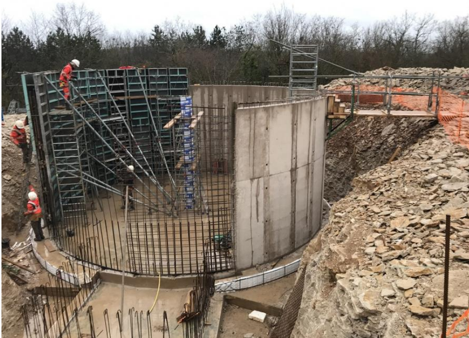
Figure I.6 Construction d'un château d'eau
