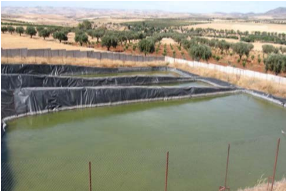
Figure II.14 : Décharge et la station des lixiviats
