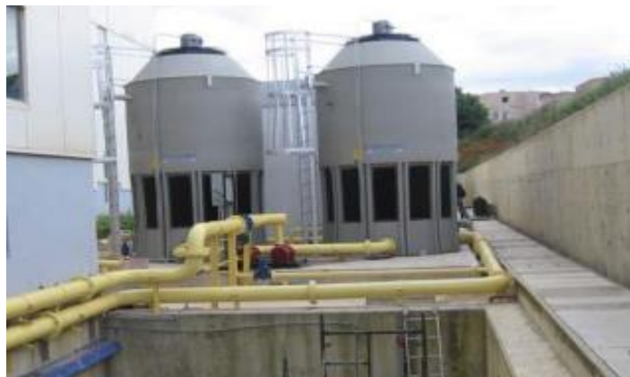
Figure 1.8: Tours de l'eau de refroidissement [9].
