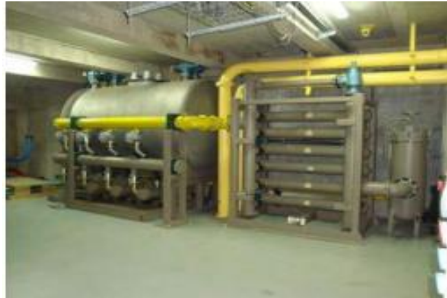
Figure 1.7: Réservoir d'huile et système de refroidissement de l'huile [9].
