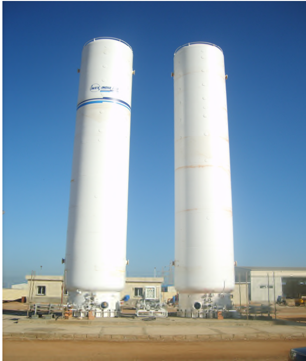
Source : COGIZ-SPA, Bacs de stockage d'Azote liquide
