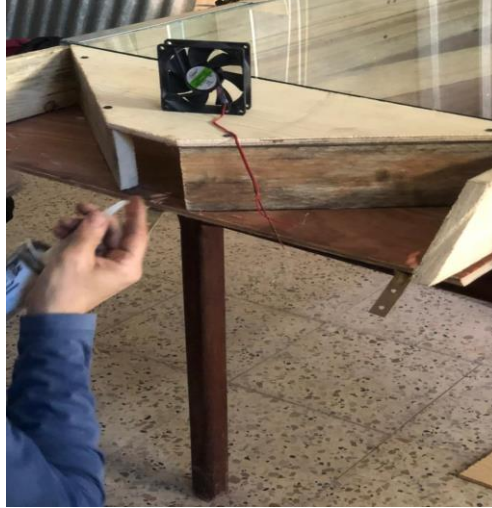
Fig. IV.7. Montage du ventilateur à la sortie du panneau
