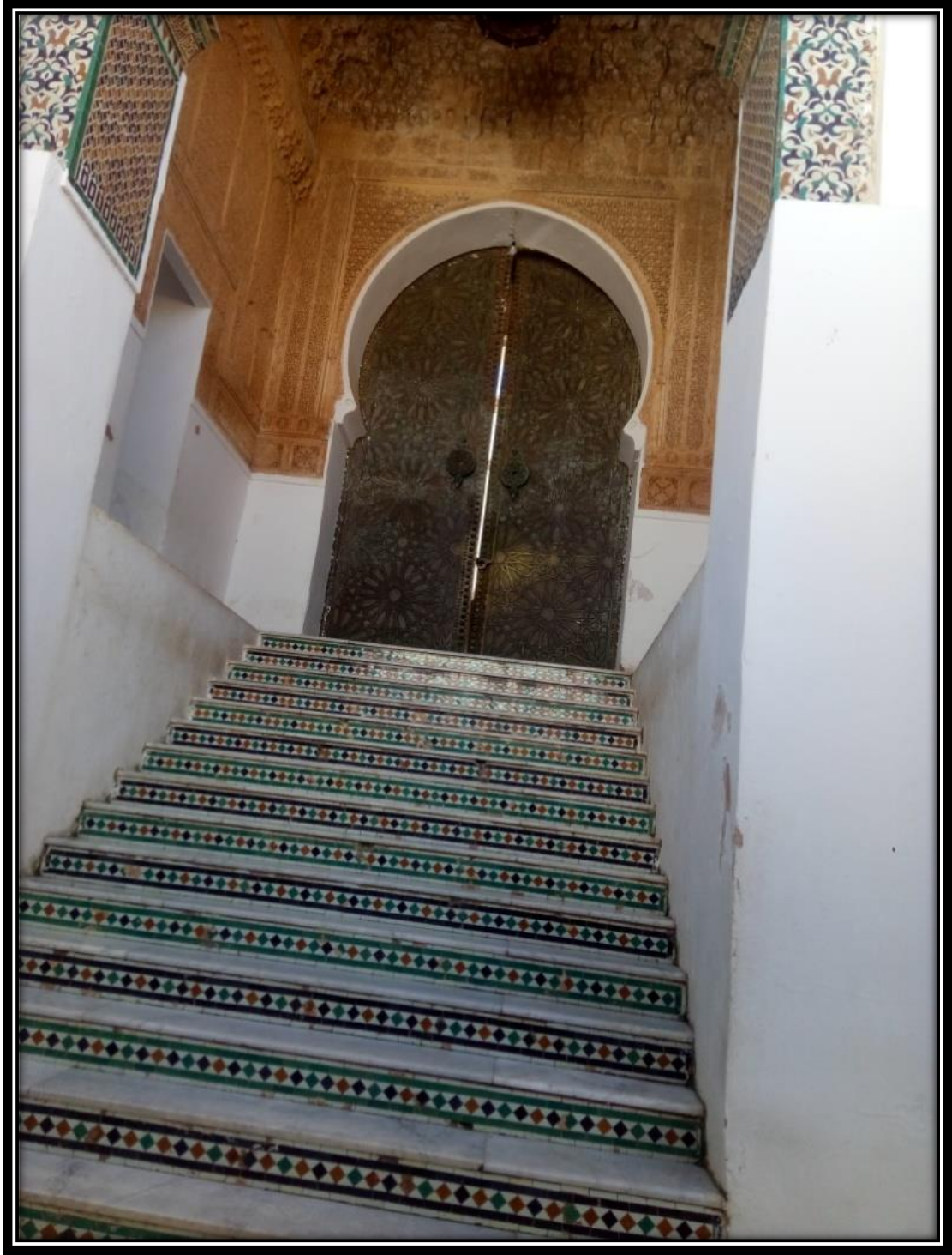
الصورة رقم 11: سلم المدخل الرئيسي. من إعداد الطالبة.
