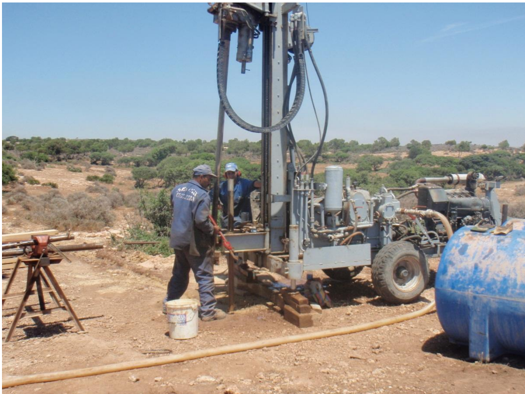
Figure 13 : La sondeuse ETSCHHEL-MEYER SCHHLADMING utilisée dans les travaux de sondage carotté.
