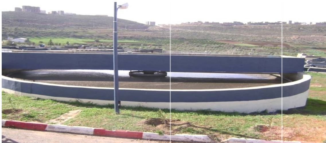
Figure I.14. Epaississeur de boue
