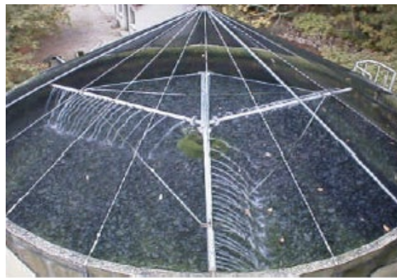
Figure II.8. Lit bactérien avec garnissage traditionnel (Séguret, 1998).
