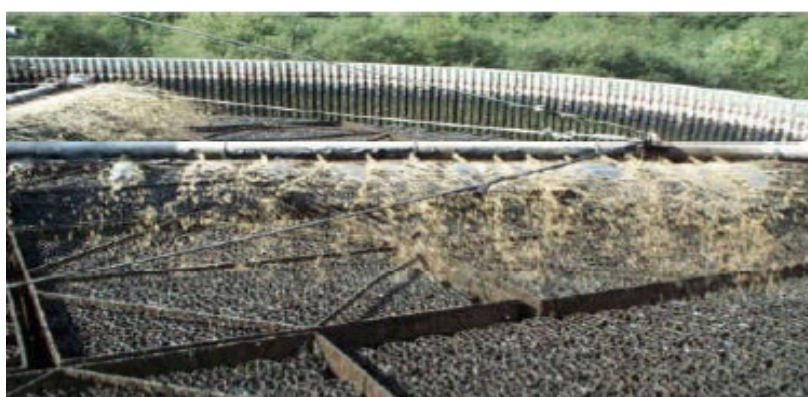
Figure II.9. Alimentation du lit bactérien (garnissage plastique) (Séguret, 1998).
