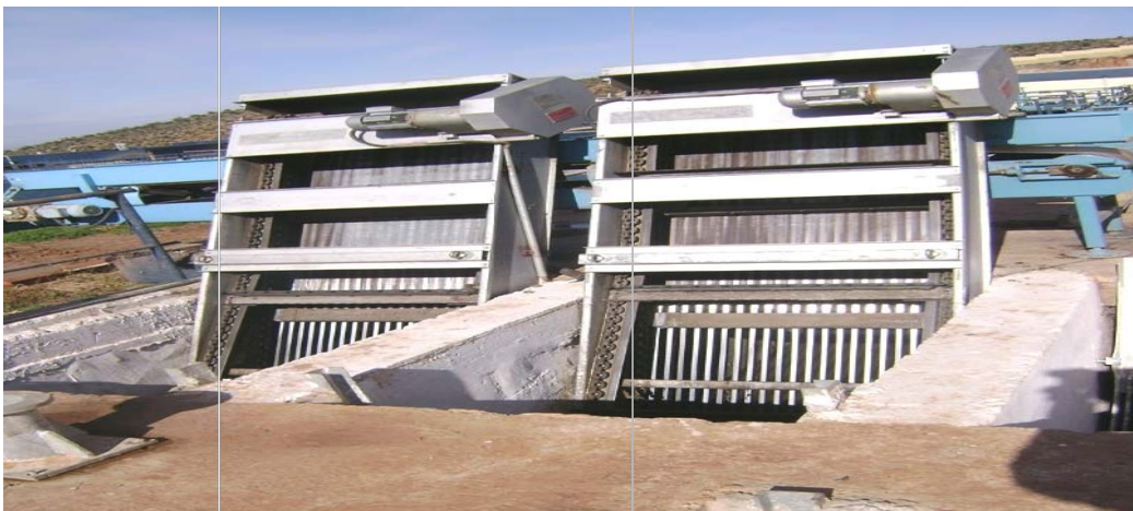
Figure I.8. Grille mécaniques
