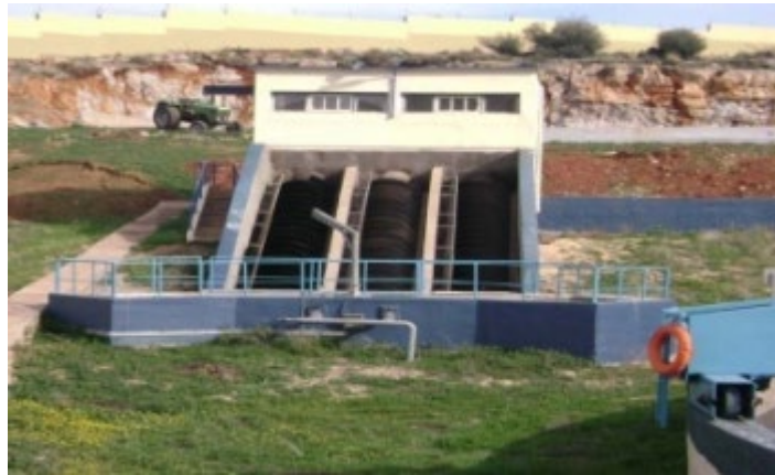
Figure I.13. Vis d'Archimède (vis de recirculation)
