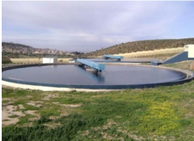
Figure I.11. Décanteurs secondaires
