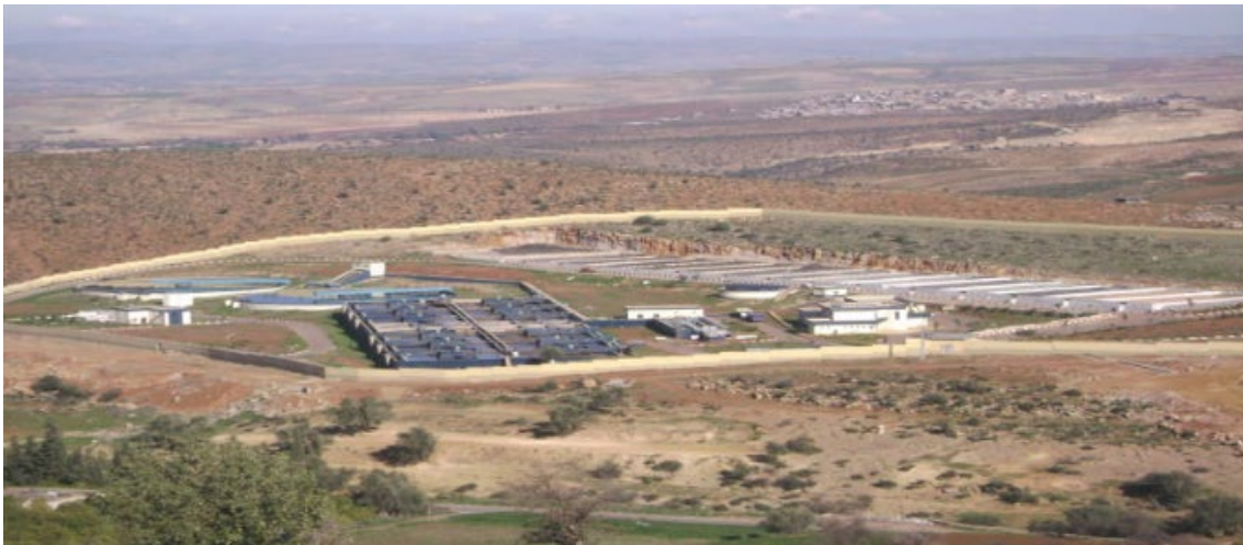
Figure I.5. Panoramique de la station d'épuration (ONA, 2006).
