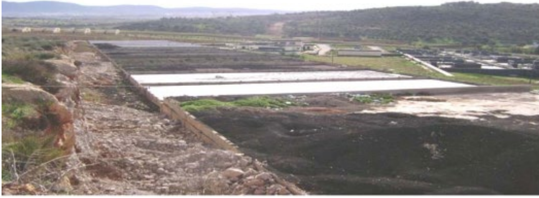
Figure I.15. Lits de séchages et aire de stockage
