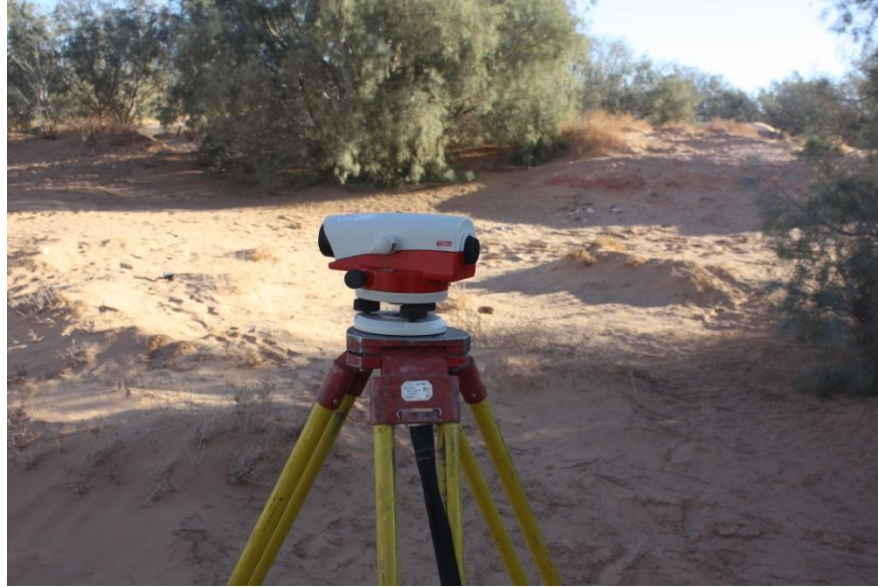
Photo 01 : Le niveau du chantier pour mesurer la hauteur de sable
