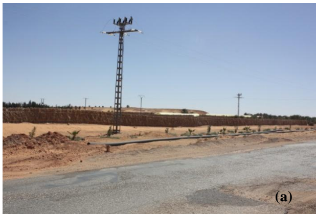
Photo 3: (a) et (b) Palissades installées pour la protection des terrains agricoles contre l'ensablement (Tinerkouk )
