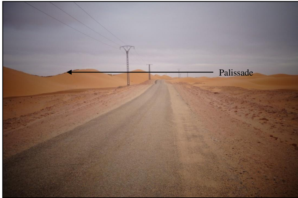
Photo 2: Palissade de protection contre l'ensablement de la route et de la ligne d'électrification Tganet - KsarKadour
