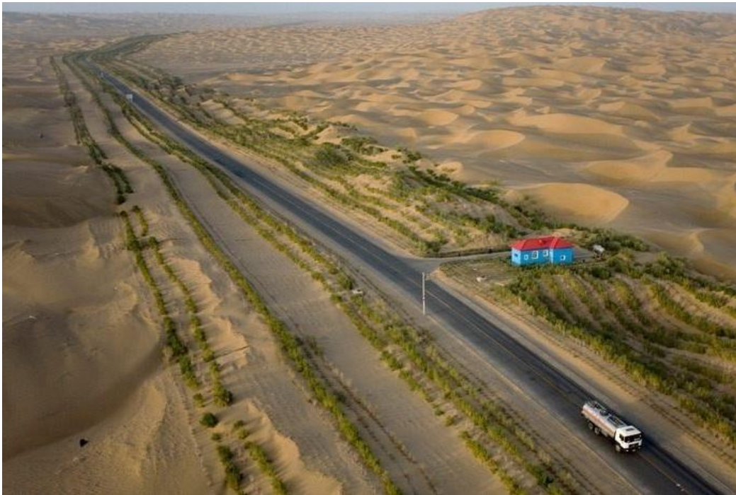
Photo 15: Protection contre l'ensablement de la route du désert de Taklamakan en Chine
