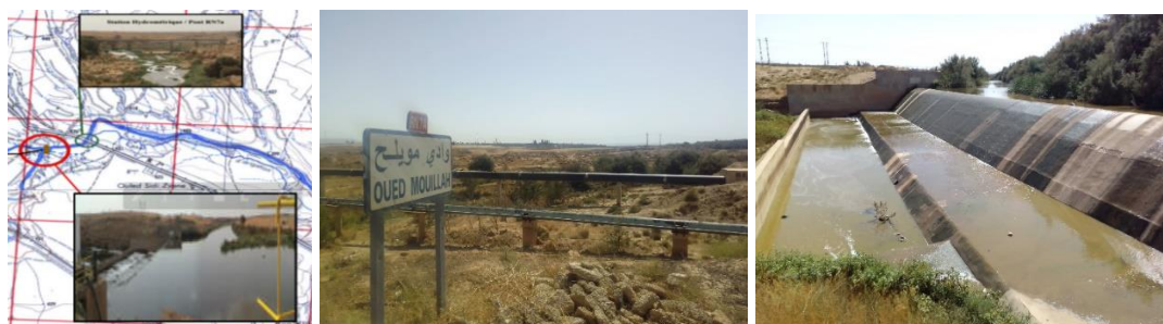
Figure 54 : Site de contrôle de la pollution marocaine par l'ANRH
