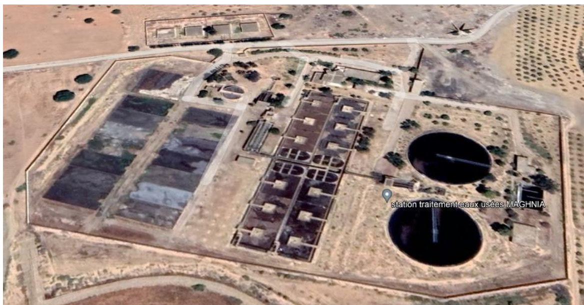
Figure 42 : Station d'épuration de Legfaf (Maghnia) par boues activées
