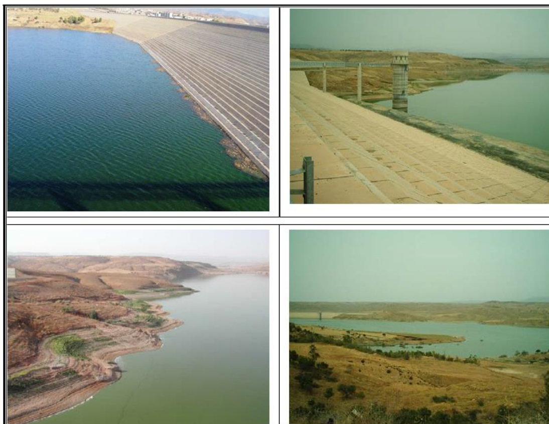
Figure 18 : Vue d'ensemble de la cuvette du barrage Hammam Boughrara
