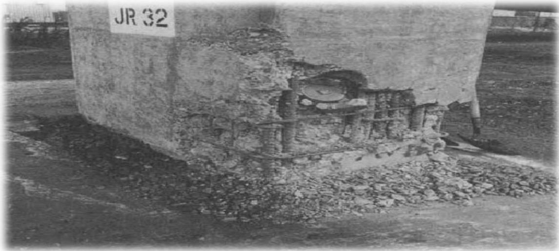
**Figure 1.19 : Rupture par perte d'ancrage des barres dans la zone de recouvrement (zone de rotule plastique) suite au séisme de Loma Prieta en 1989.[16]**
