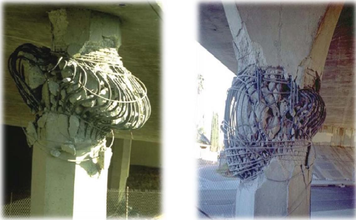
**Figure 1.21: Rupture de piles de pont par cisaillement lors du séisme de Northridge,1994.[10]**
