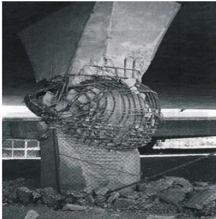
**Figure 1.13 : Rupture par manque d'armatures transversales lors du séisme de Northridge 1994. [8]**
