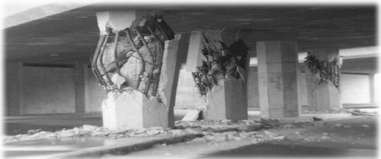
**Figure 1.8:Rupture en cisaillement des piles de pont (San Fernando en 1971)**
