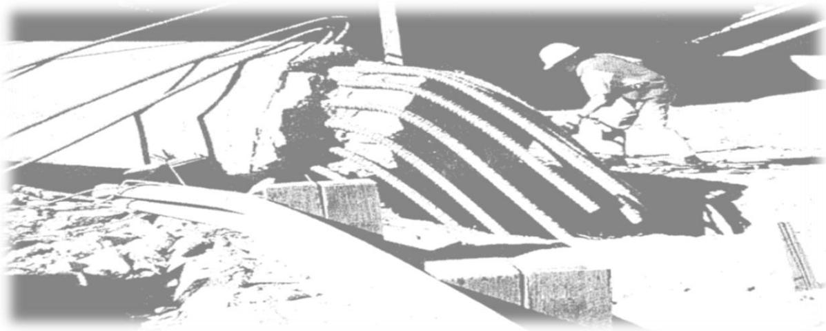
**Figure 1.14 : Rupture de l'armature à la base d'une colonne (San Fernando 1971).[10]**
