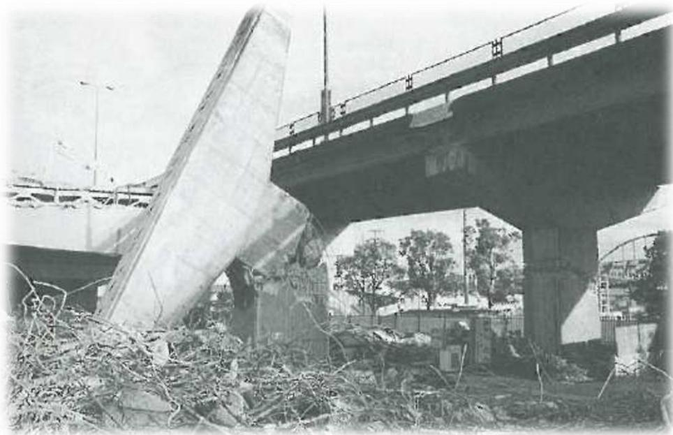
**Figure 1.10 : Rupture d'une pile en flexion-cisaillement (Kobe, 1995) [10]**
