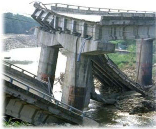
Figure 1.2 : Endommagements de pile de pont lors du tremblement de terre de taiwan en 1999
