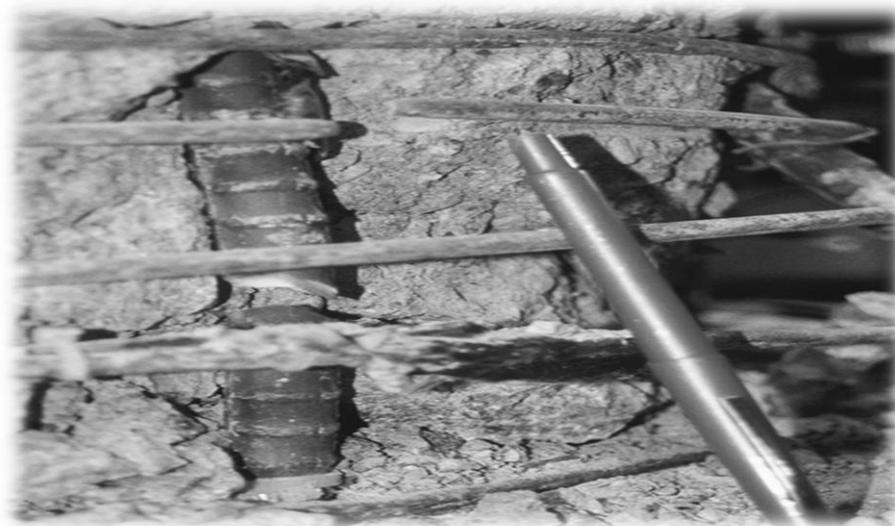
**Figure 1.32 : Flambement des barres longitudinales. [25]**
