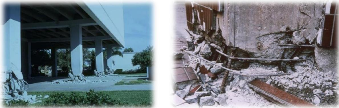
**Figure 2.10 : Rupture par formation des rotules plastiques aux pieds des poteaux [39]**
