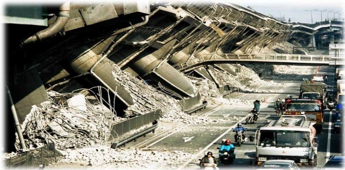
**Figure 2.11 : Rupture des piles lors du séisme de Kobé 1995 en Japon**
