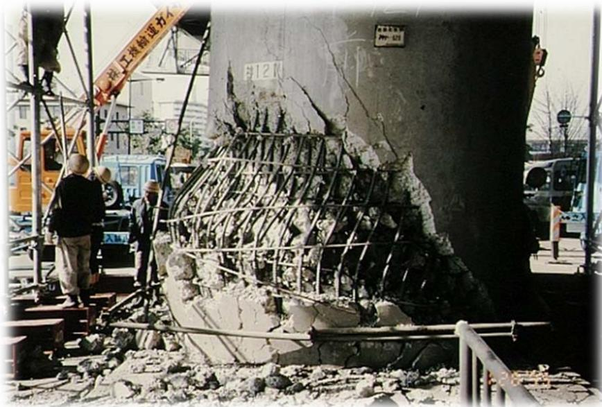
**Figure 1.20 : Rupture par manque de ductilité à la base de la pile durant le séisme de Kobe en 1995.[8]**
