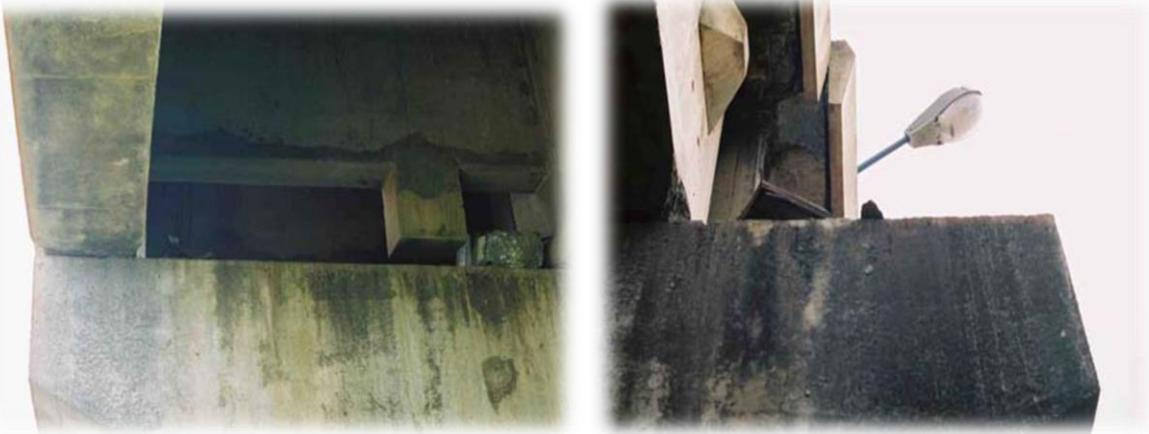
**Figure 1.25 : Déplacements et translations des poutres des tabliers.**
