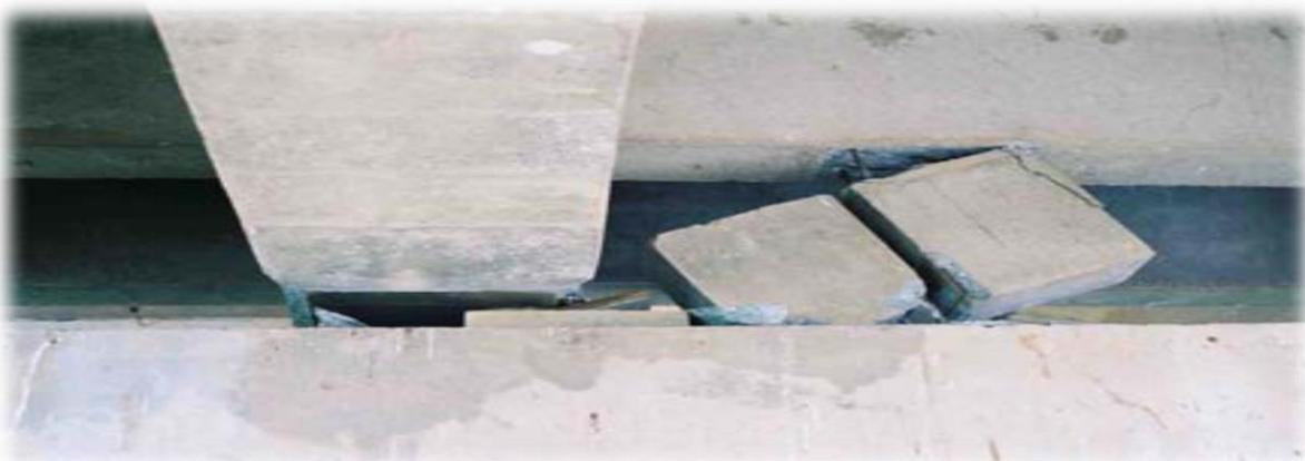
**Figure 1.24 : Endommagement des bloqueurs de déplacements latéraux.**
