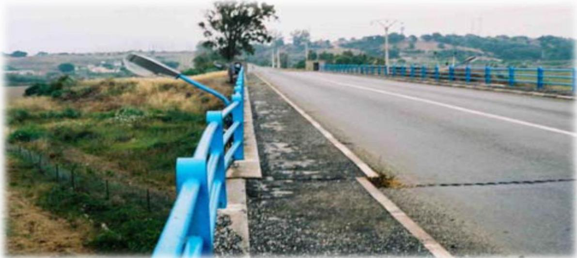
**Figure 1.23 : Ouvertures des joints de chaussées.**
