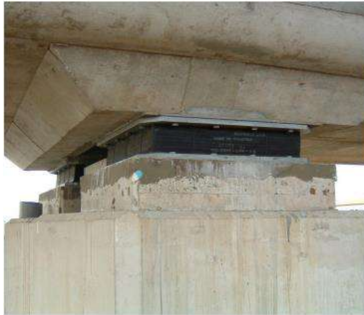
Figure 5.2 : appareil d'appui en élastomère frette [7].
