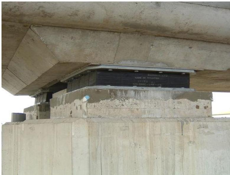
**Figure 27: Photo réelle d'un appareil d'appui**
