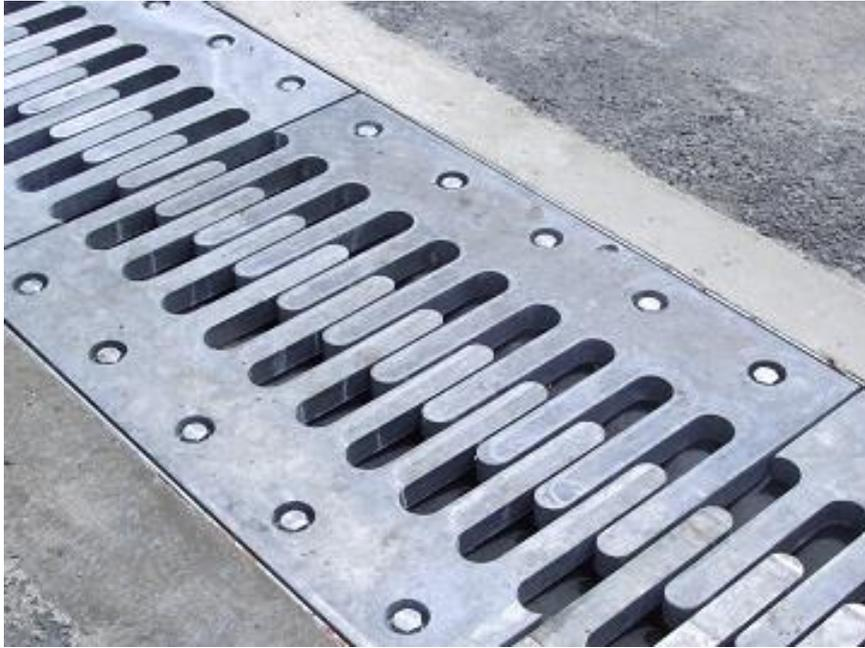
Figure 33: joint de chaussée
