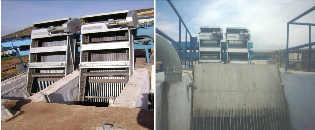
*Photo A.3: Dégrilleur (à droite dégrilleur manuel, à gauche dégrilleur mécanisé)*
