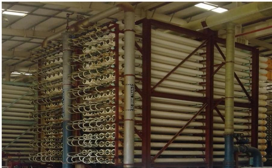
**Figure N° 6 :** Train de filtration par osmose inverse dans la station de dessalement de Souk Tlata.
