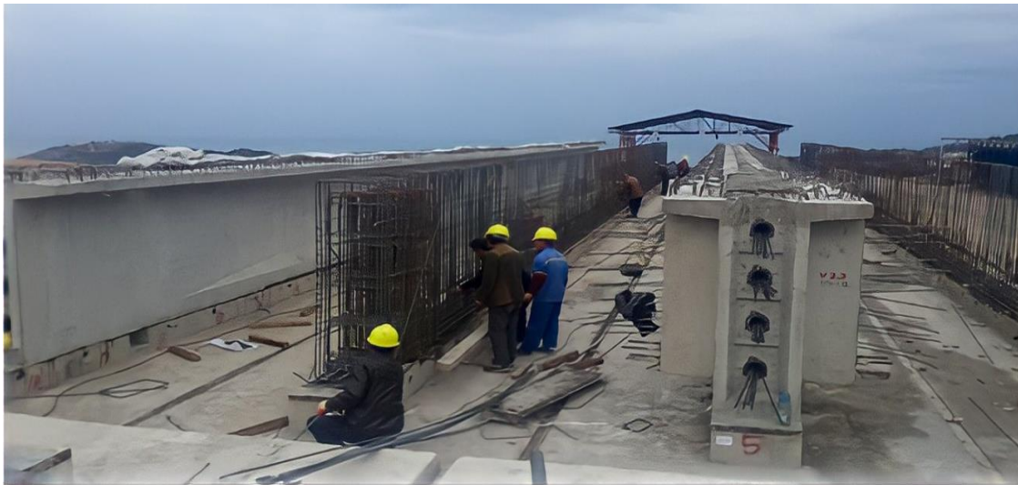
Figure 2.3 : Travaux de façonnage du ferrailage d'une poutre précontrainte
