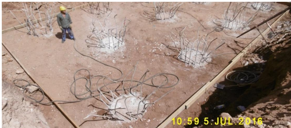
Recepage des pieux
