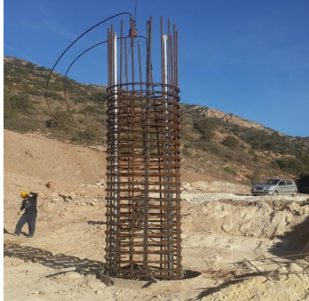
Introduction de la cage d'armatures du pieu
