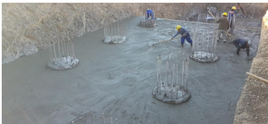
Réalisation du béton de propreté
