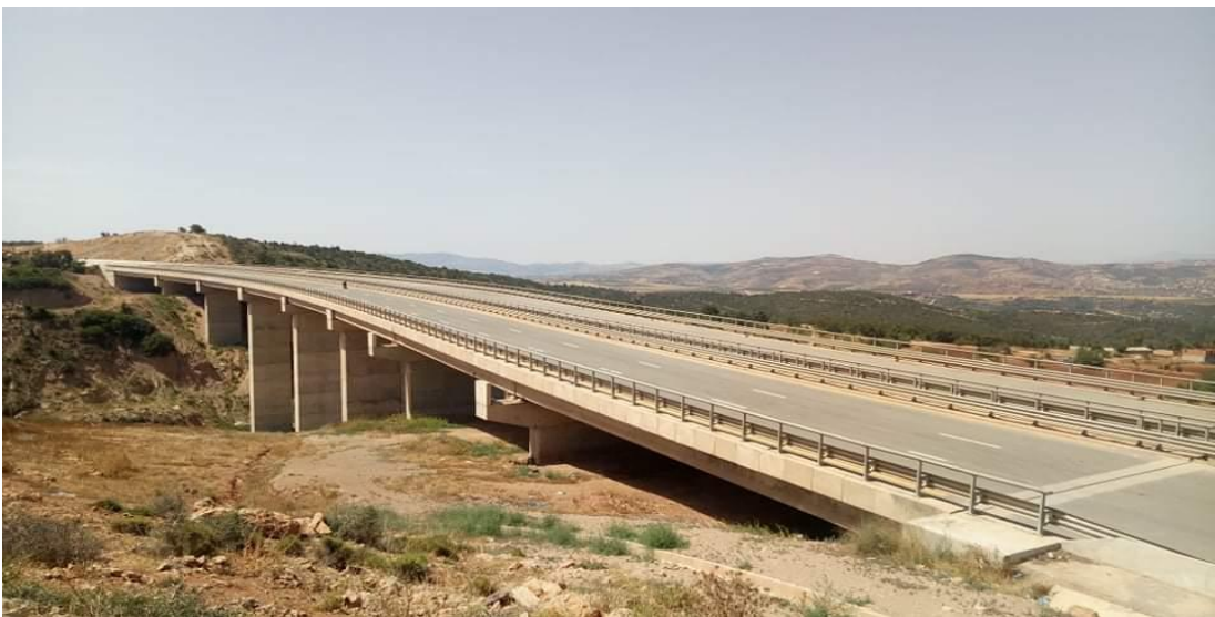
Photos du viaduc V4.0, après réalisation
