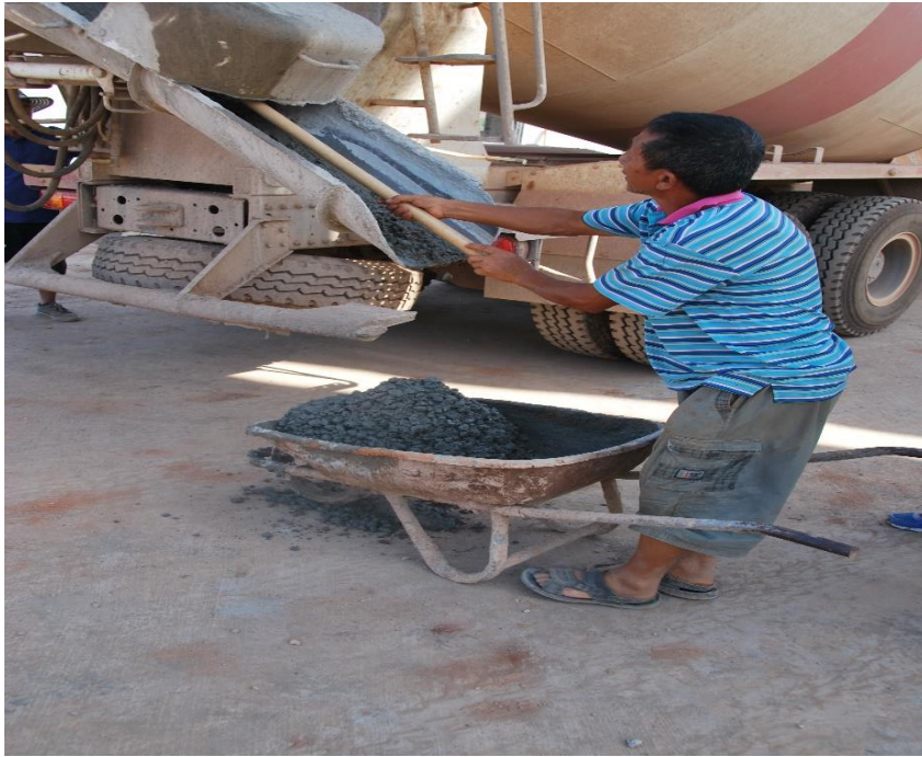
Contrôle de béton
