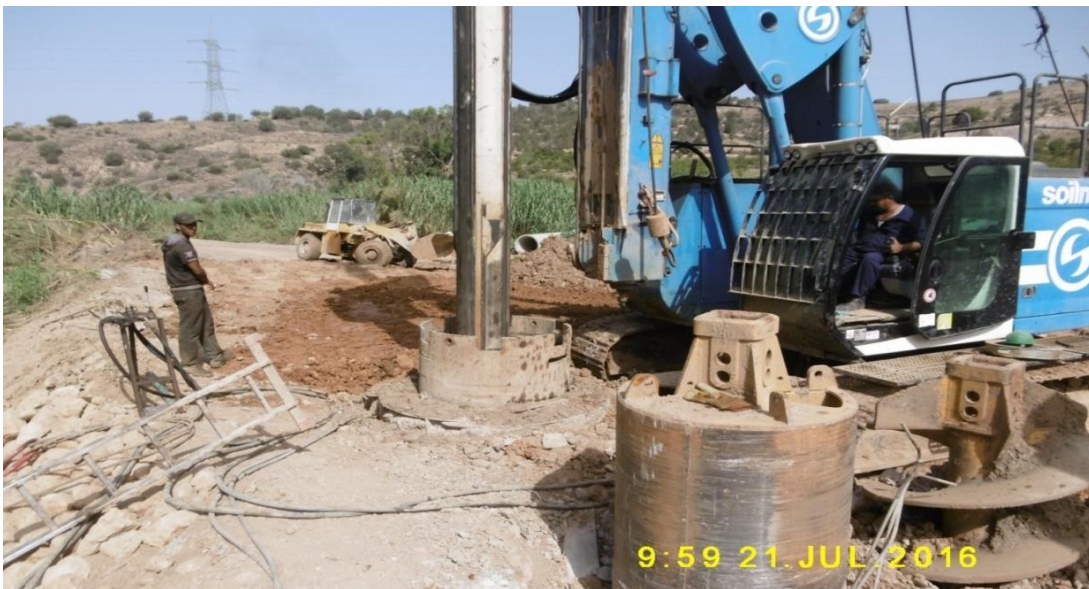
Travaux de forage des pieux
