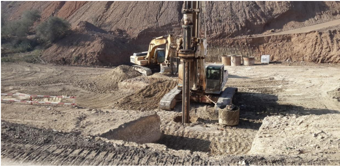
L'opération de forage des pieux
