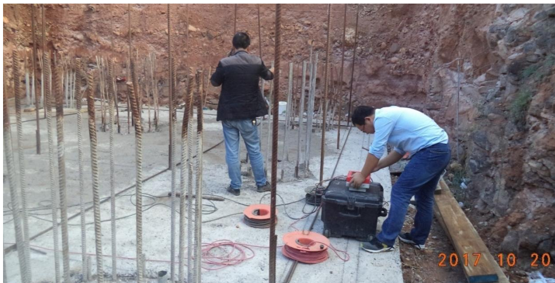
L'essai sonore pour pieux
