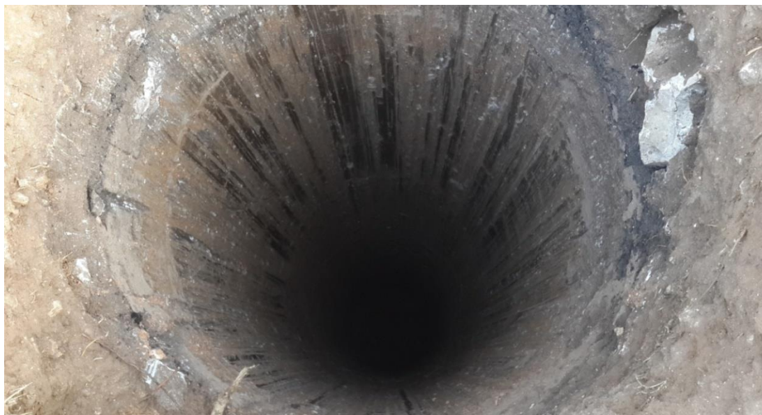
Photo d'un pieu de diamètre de 1.2m
