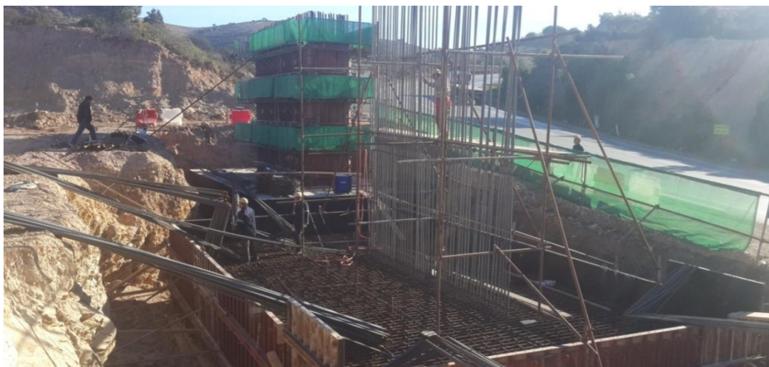
L'opération de coffrage de la semelle et le ferrailage de la pile
