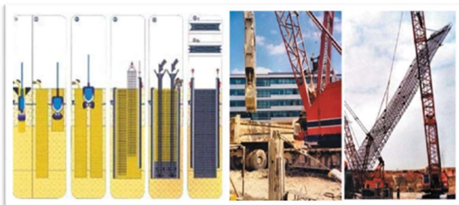
Figure 1.12 : Exemple des parois moulées.
