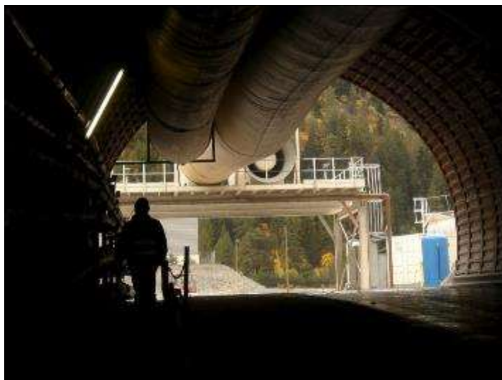
Figure 1.25 : Galerie de reconnaissance du tunnel Lyon-Turin. (Modane, Savoie, 2006). BRGM - F. Deverly.
