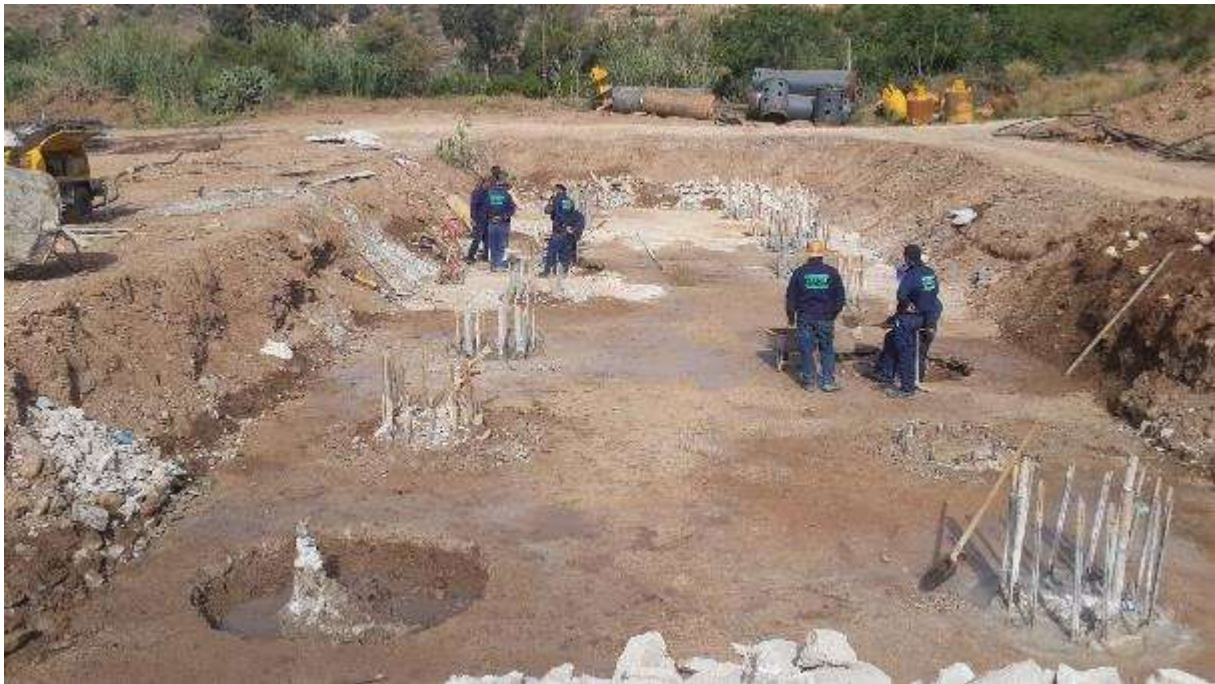
Photo D.3 : Travaux de repçage des pieux
