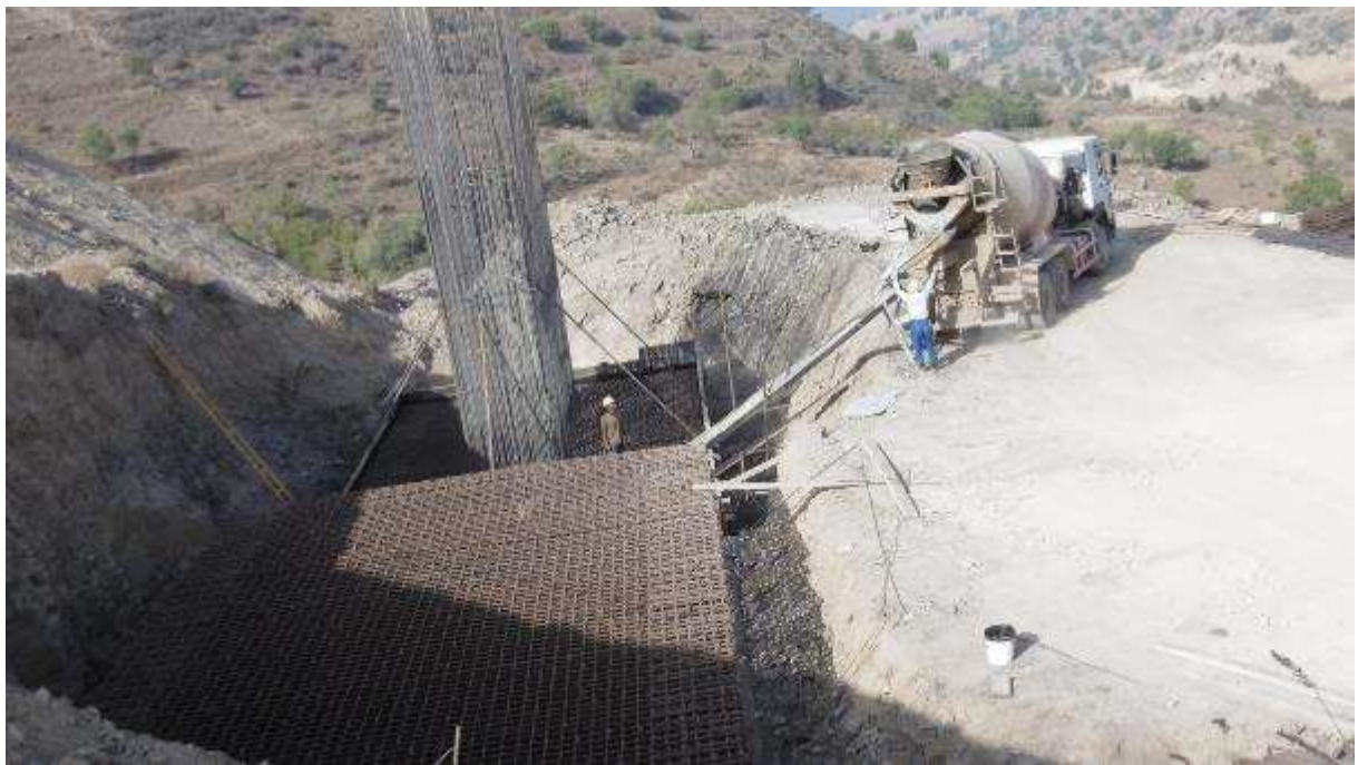
Photo D.5 : Bétonnage des semelles
