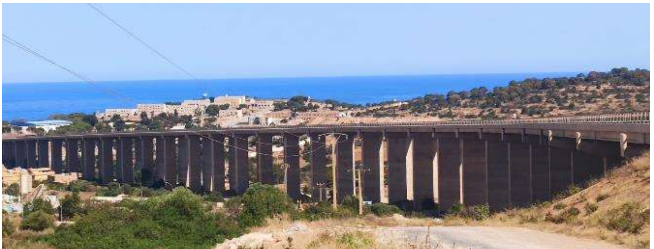
Figure 3.4 : Vue latérale du viaduc V2.3 de la pénétrante de Ghazaouet
