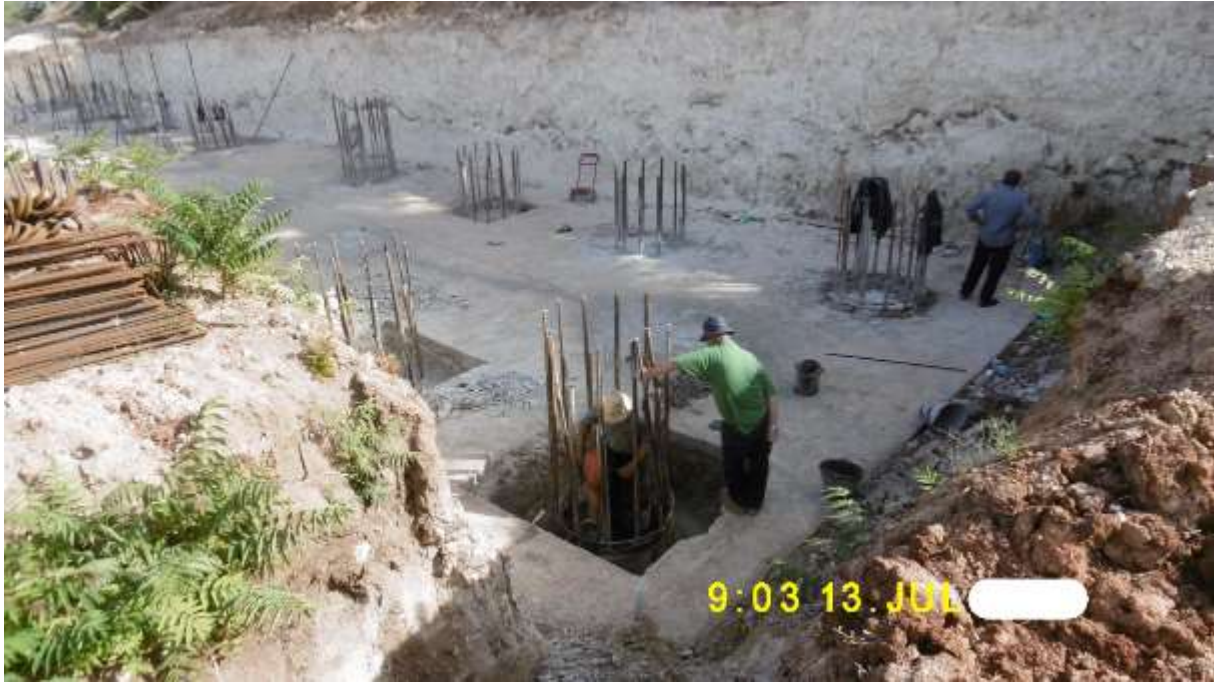
Photo D.4 : Bétonnage des pieux
