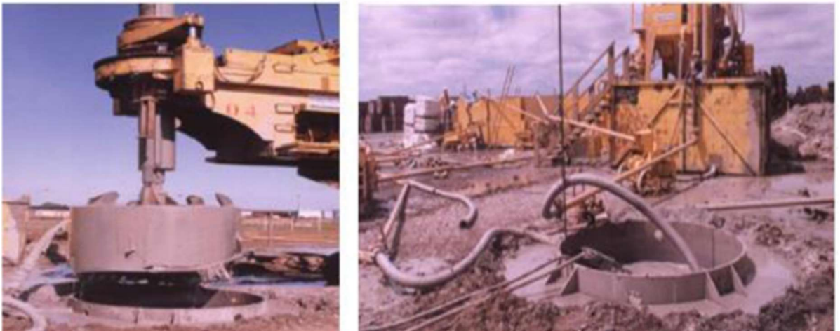
Figure 1.8: Pieux forés avec boue.
