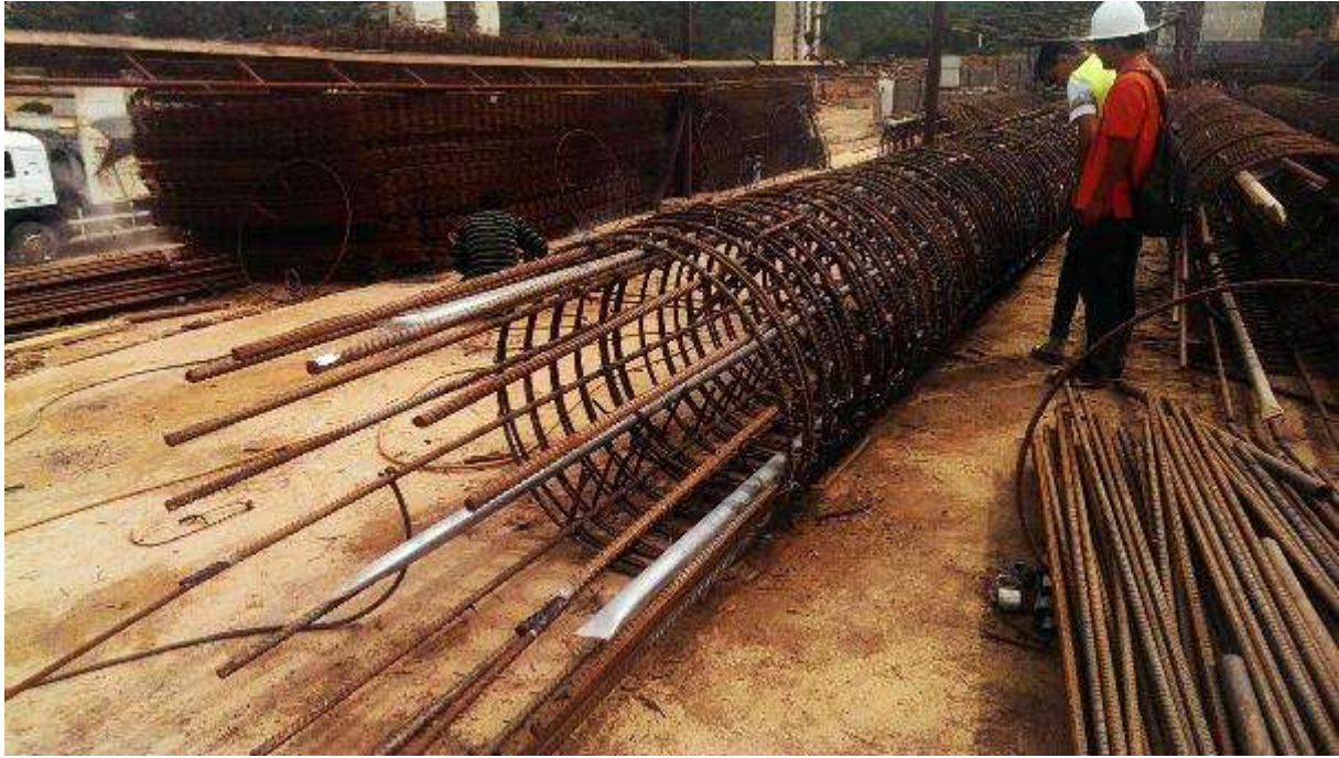
Photo D.2 : Cage d'armatures des pieux
