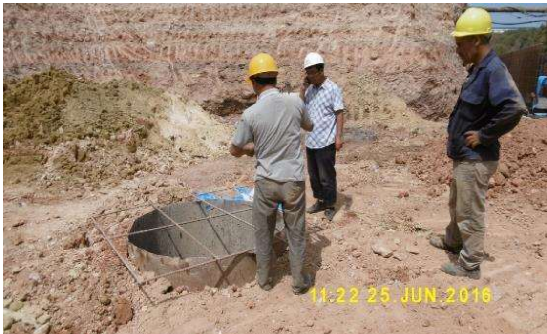
Photo D.1 : Travaux de forage des pieux
