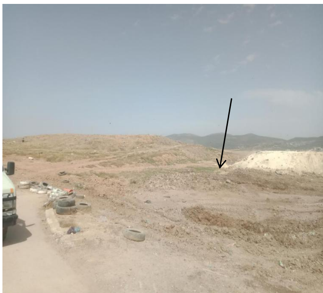
Figure 31: casier plein et remblayé
