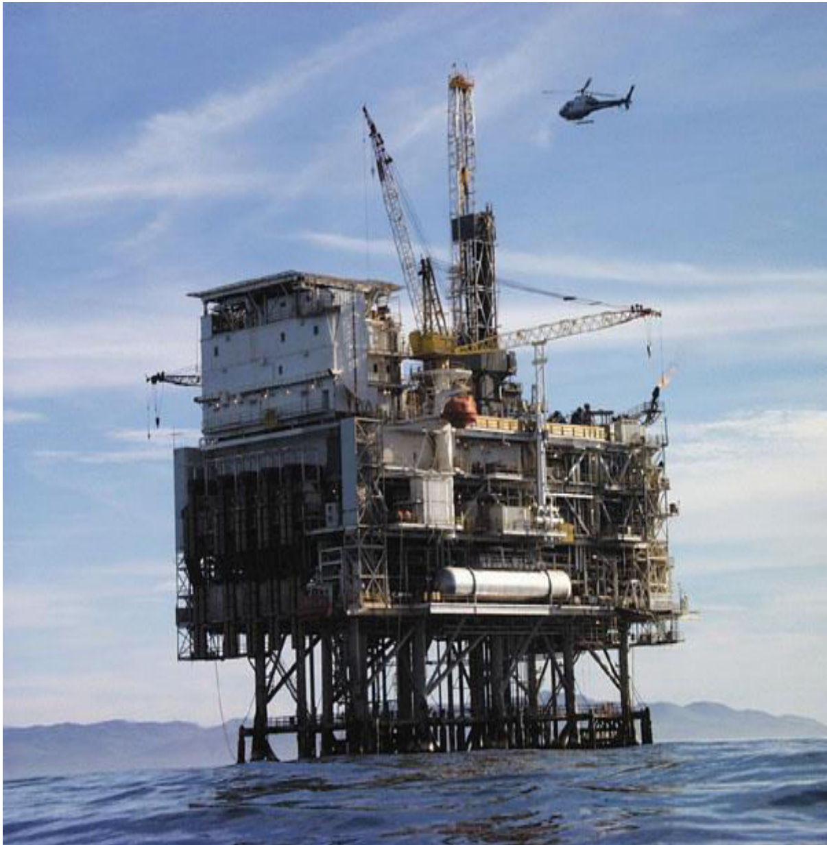
Figure 20 : Plate-forme pétrolière (Wikipédia)
