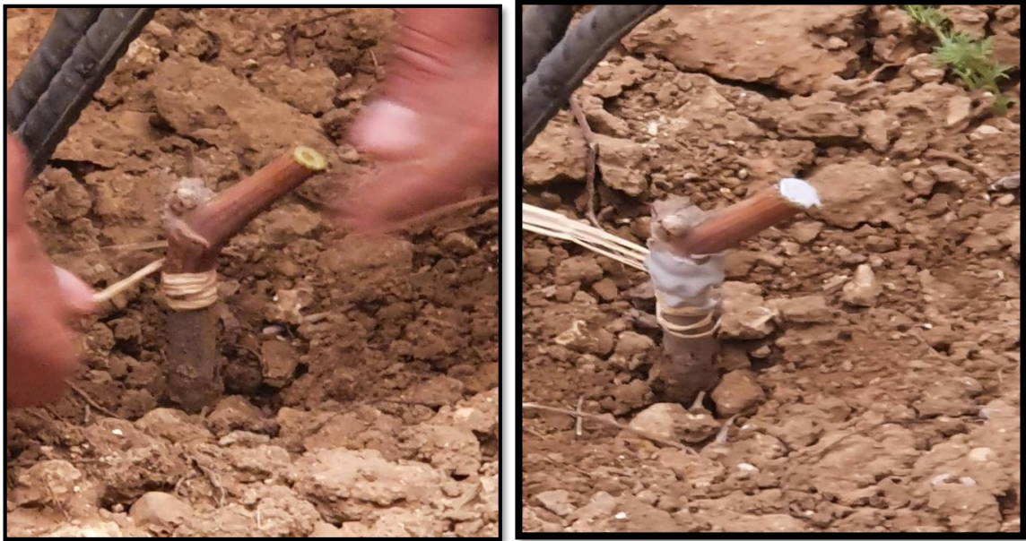
Figure III-7 : point de soudure par le raphia et le mastic
