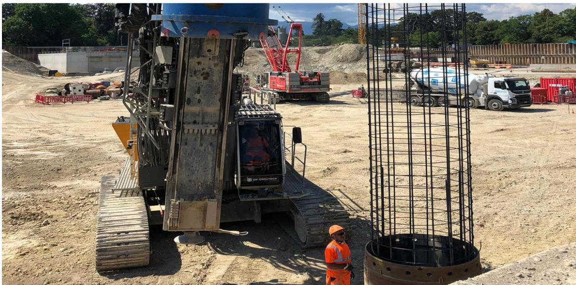
**Figure 21 Mise en place du ferrailage**
