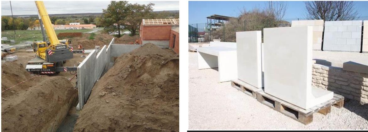
**Figure 30 Réalisation des parois préfabriquées en béton armé**
