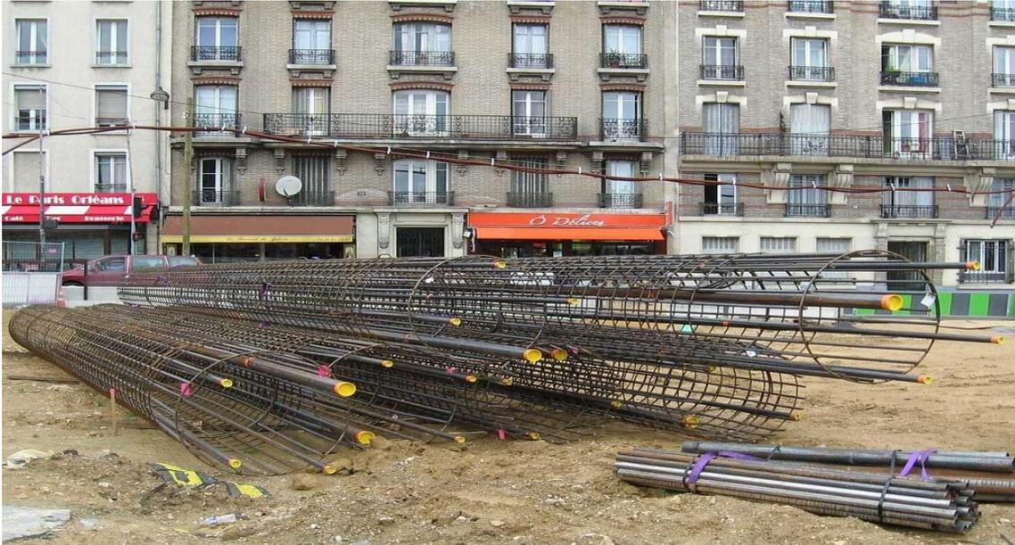
**Figure 20 La cage d'armature**
