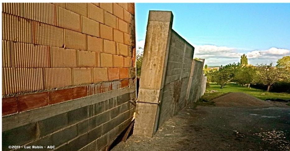
**Figure 37 Le renversement d'un mur de soutènement**
