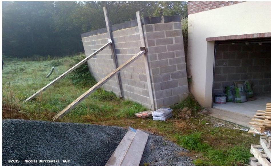
**Figure 38 Défaut de calcul d'un mur de soutènement**
