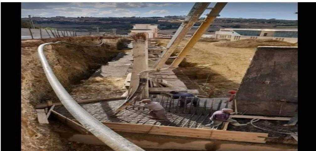
**Figure 25 Coulage d'une semelle filante**
