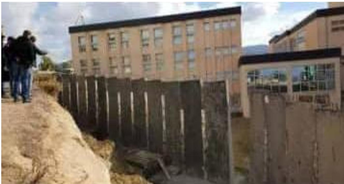
**Figure 6 Pose des murs de soutènement**
