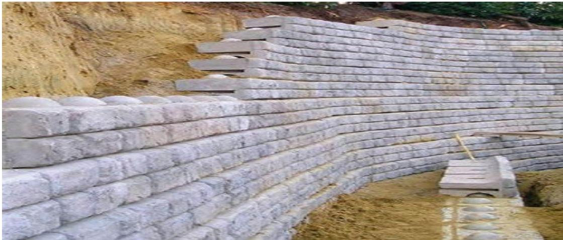
**Figure 26 Réalisation des murs poids**
