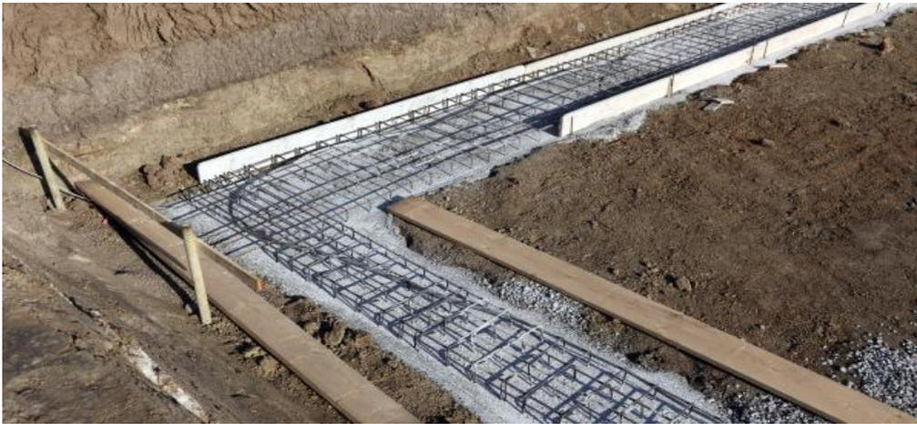
**Figure 24 Ferrailage d'une semelle filante**
