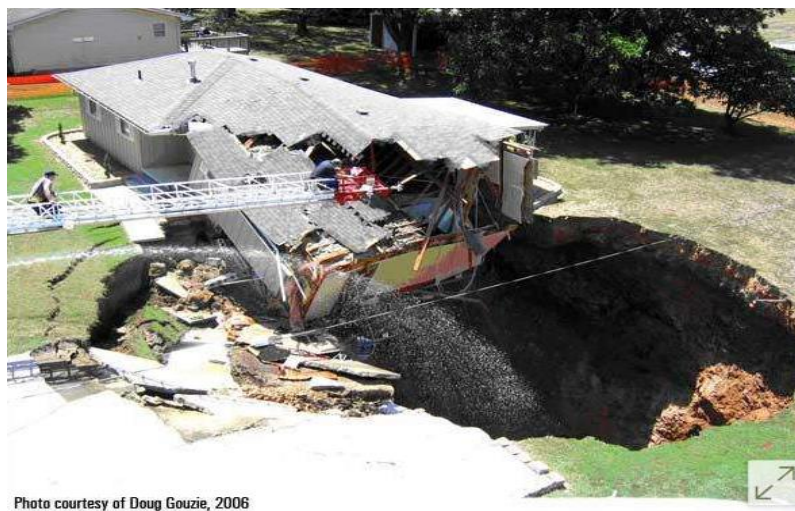
Figure 1.1 Endommagement de maison à la suite d'un effondrement en Floride (2006)
