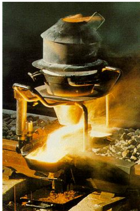
Figure I.10 : Soudage aluminothermique. [3]
